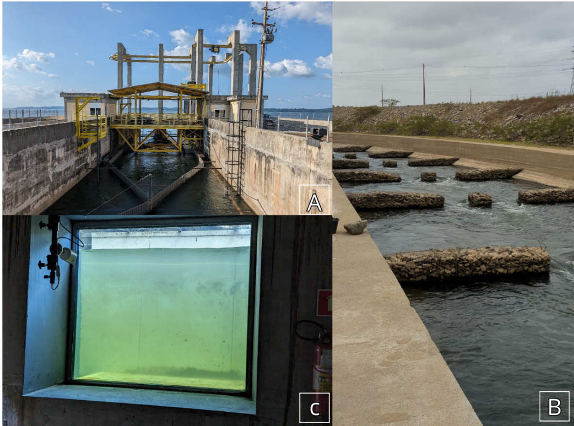
Figura 3: Vista externa do STP (A), Visor e sala de monitoramento do STP(C) e canal do STP (B)
