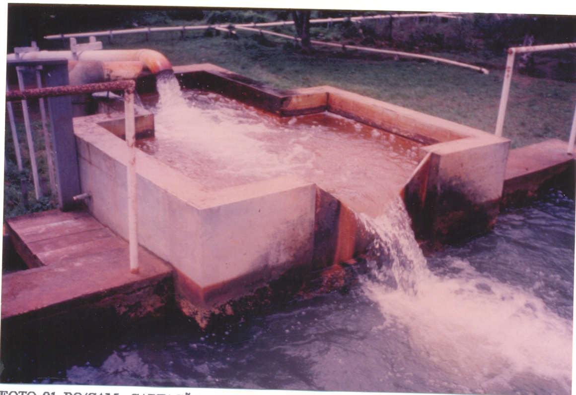
FOTO 01. PO/CAM - CAPTAÇÃO CAMPINHO (CAPANEMA). CAIXA RECEPTORA DE 24 POÇOS. PROFUNDIDADE MÉDIA DOS POÇOS 9 - 12 m.
