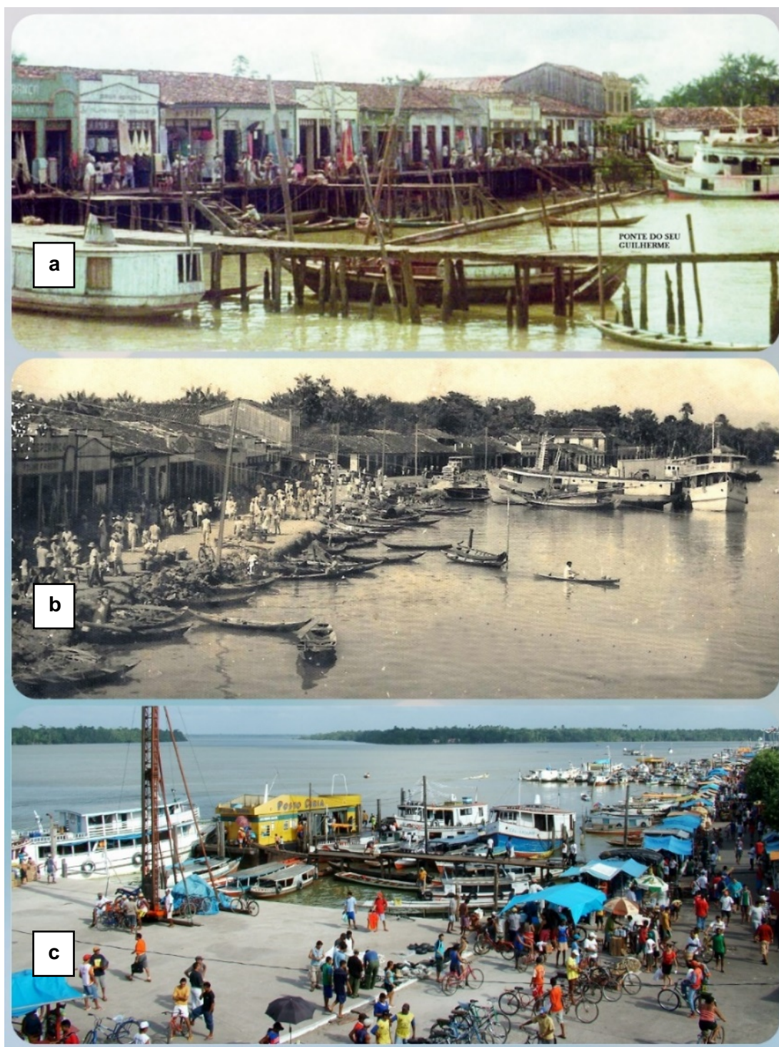
Figura 3 - Beiradão de Abaetetuba, Pará, em distintos períodos: (a) as pontes eram a continuidade das primeiras ruas da cidade. Cada comércio tinha uma ponte de palafita para que os barcos e canoas que vinham das ilhas pudessem atracar (imagem de 1800-1810); (b) o aterro da calçada do beiradão começou em 1961; e (c) em 1998 foi retirada a ponte grande de madeira e começou a sua construção em alvenaria, com posteriores reformas. Fonte: Arquivo pessoal de Raimundo Lima (2020).
