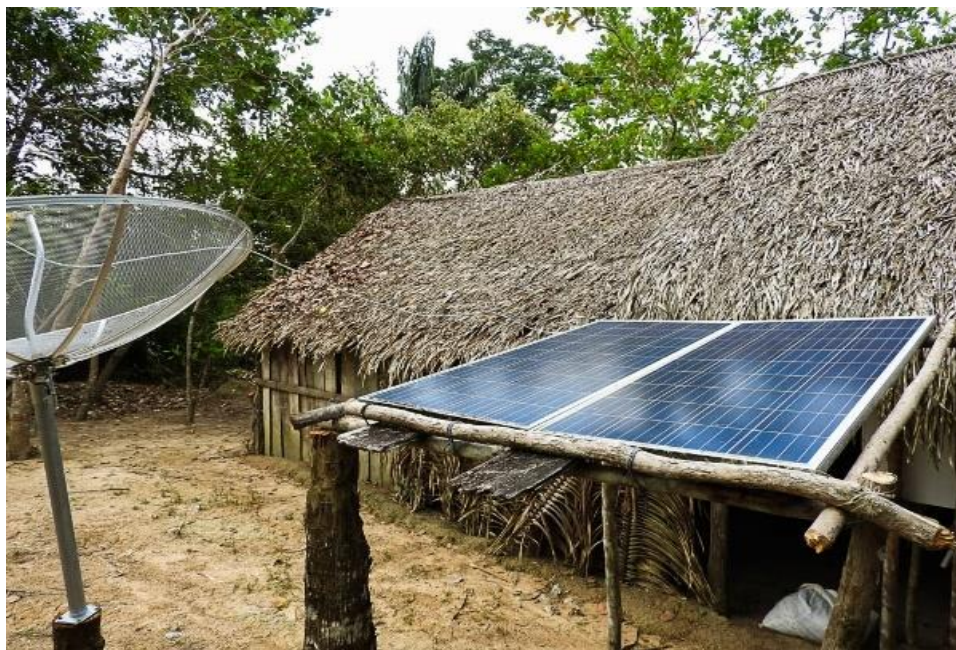
Figura 51 - Antena de recepção de sinal de TV via satélite e painel solar que converte luz solar em eletricidade na CBE
