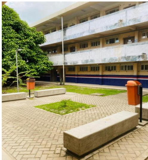
FIGURA 6 - Terceiro Bloco da Escola Benvinda de Araújo Pontes
