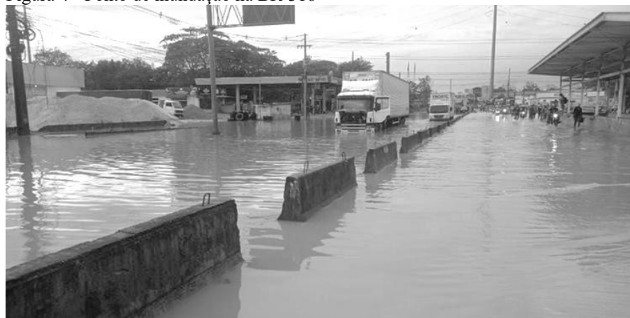
Figura 4 - Ponto de inundação na BR-316
