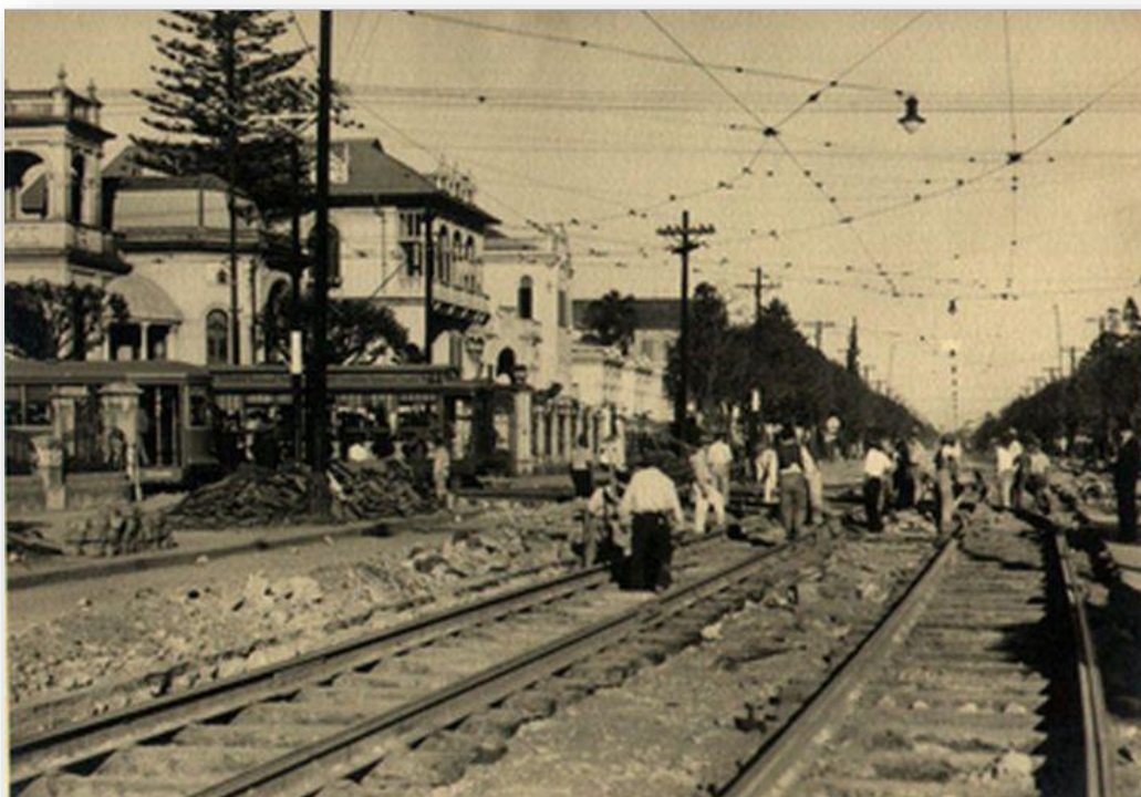
Figura 68 - Obras de e reforma na pavimentação da via - 1935
