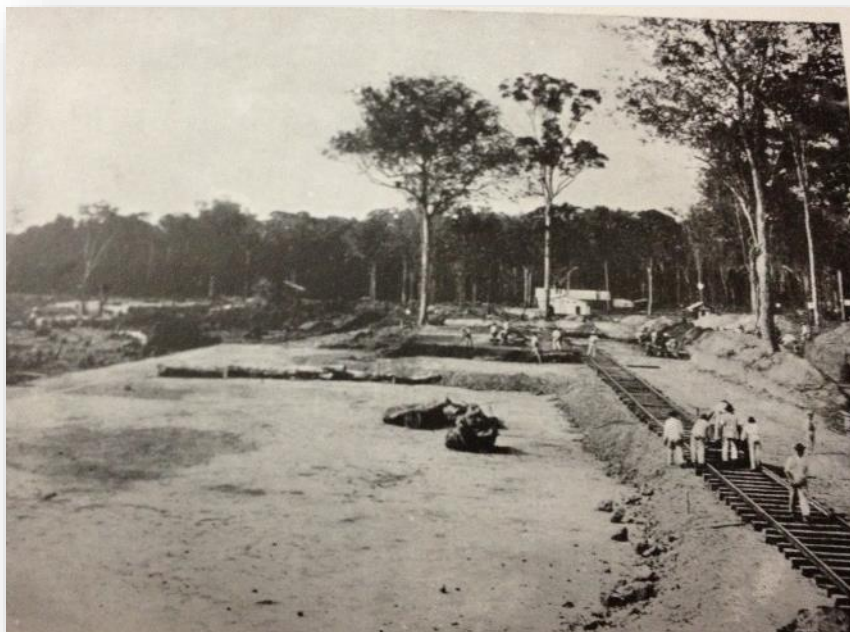
Figura 86 - Serviço de nivelamento do solo em Val de Cans nas oficinas construtoras do Porto
