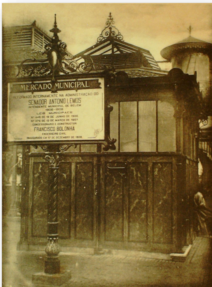
Figura 122 -Instalação Sanitária do Mercado da Carne
