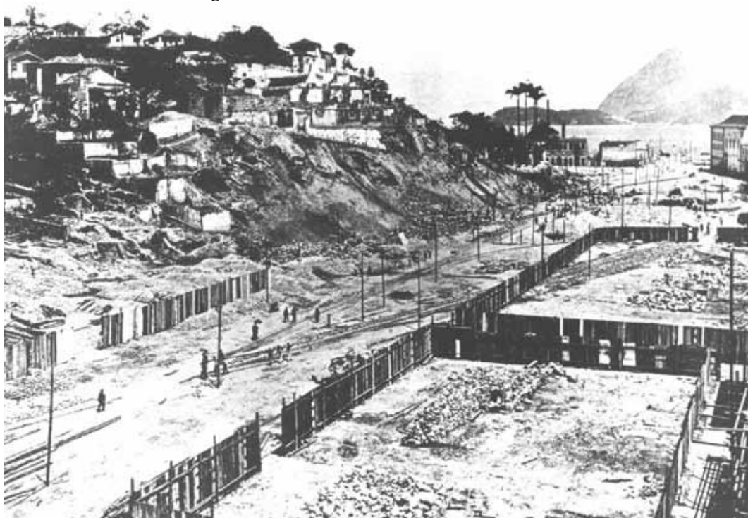
Figura 63 - Obras de abertura da avenida Central
