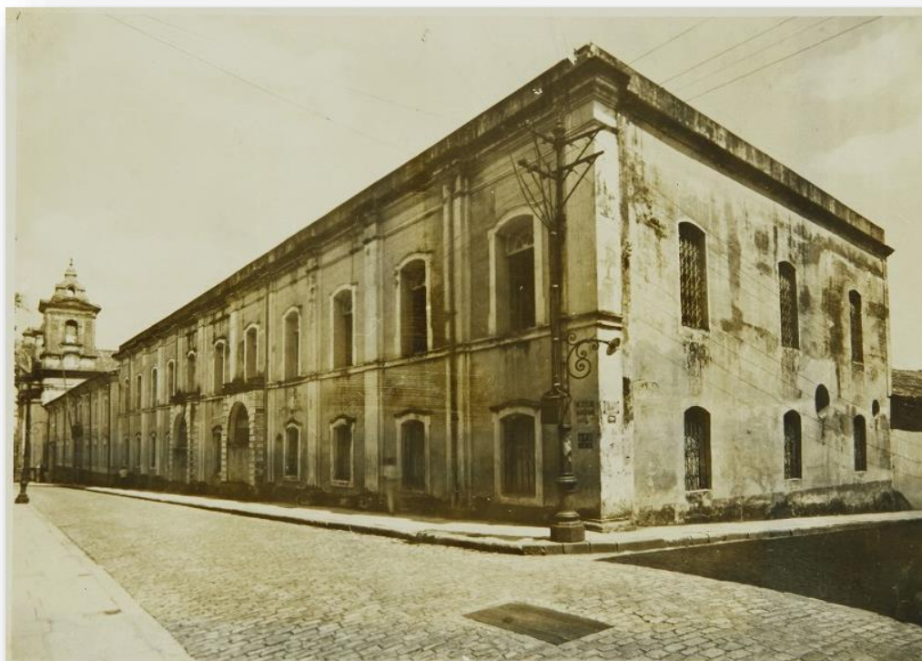
Figura 49 - Prédio anexo a Igreja das Mercês, 1959. Vista dos fundos da Alfândega
