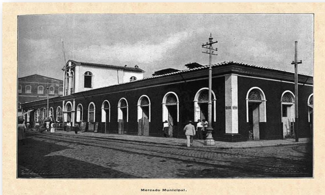
Figura 52 - Mercado municipal antes da reforma. Apenas pavimento térreo
