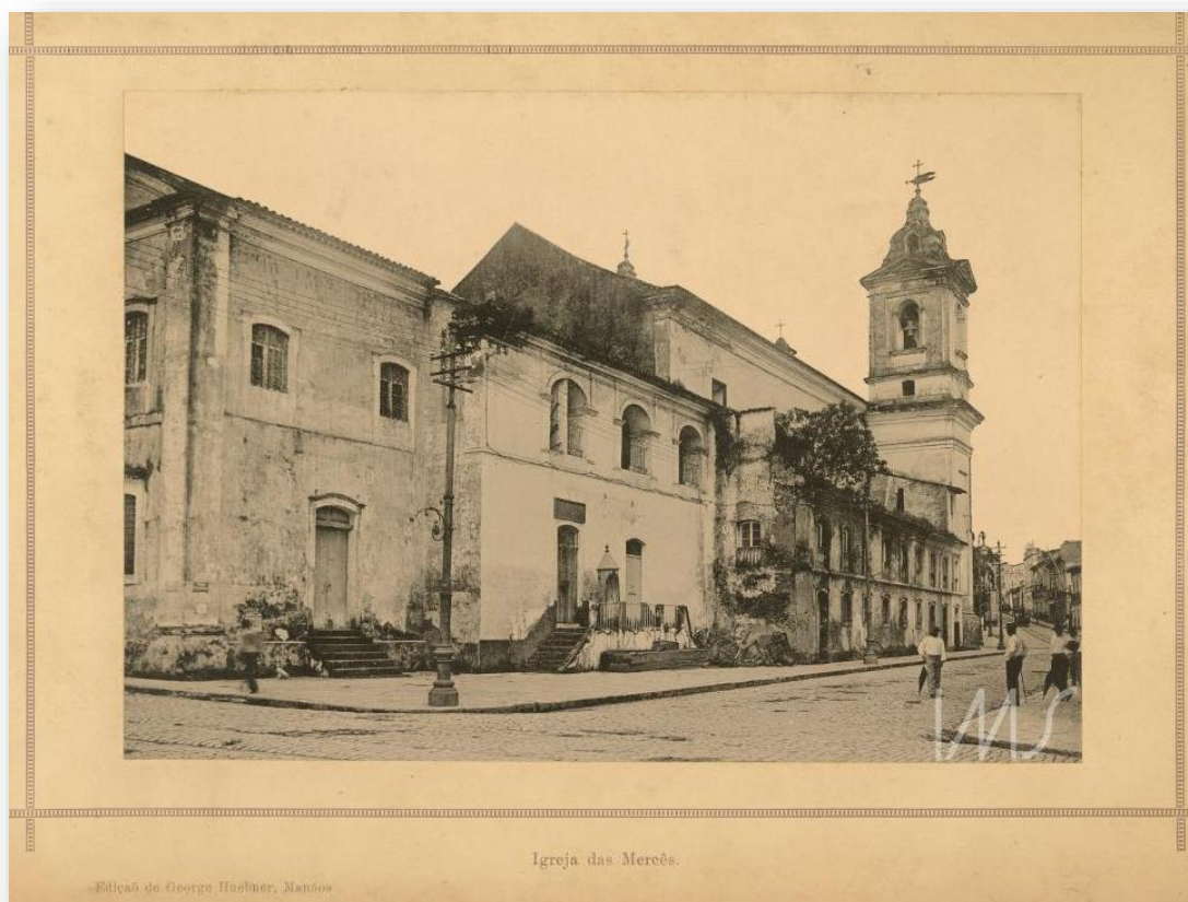
Figura 35 - Igreja das Mercês situada na Tv das Mercês confluência com Rua Nova do Imperador
