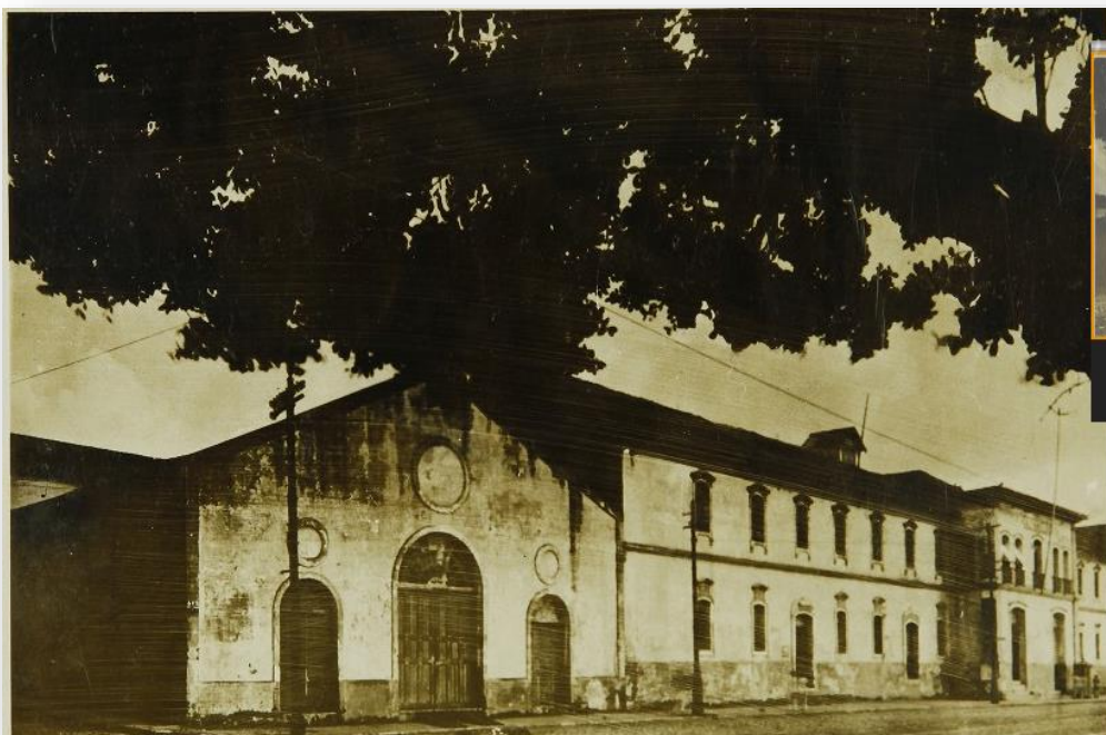
Figura 48 - Edificação anexa a Igreja das Mercês. Alfândega, 1959.
