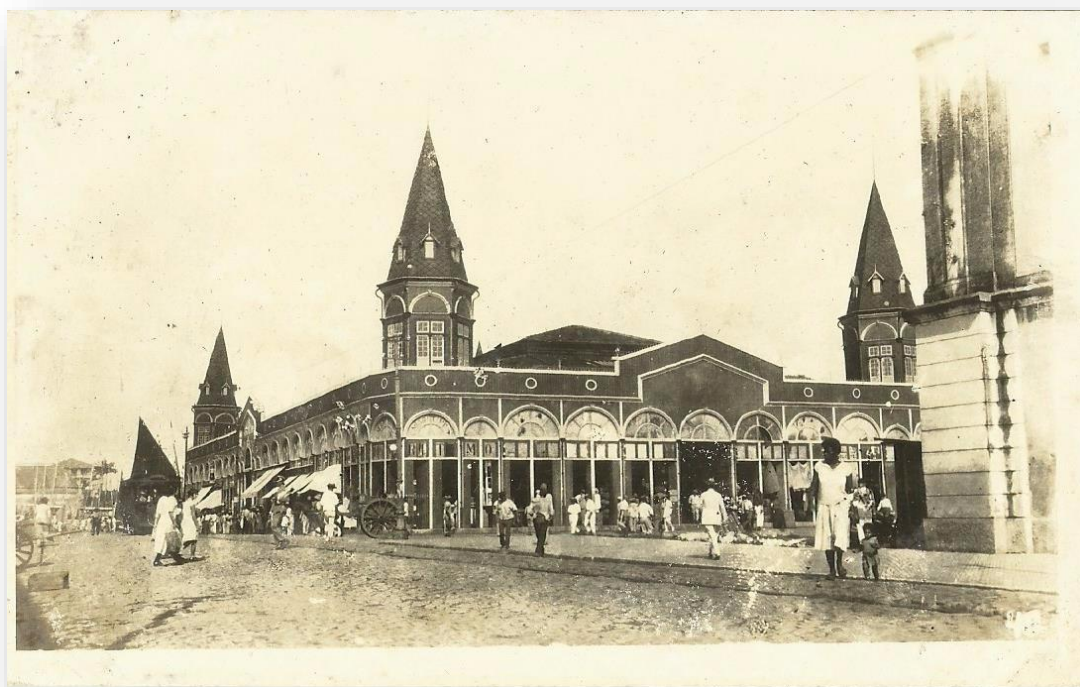
Figura 156 - Mercado de Ferro – Hotel do Povo próximo a entrada pela Baía do Guajará
