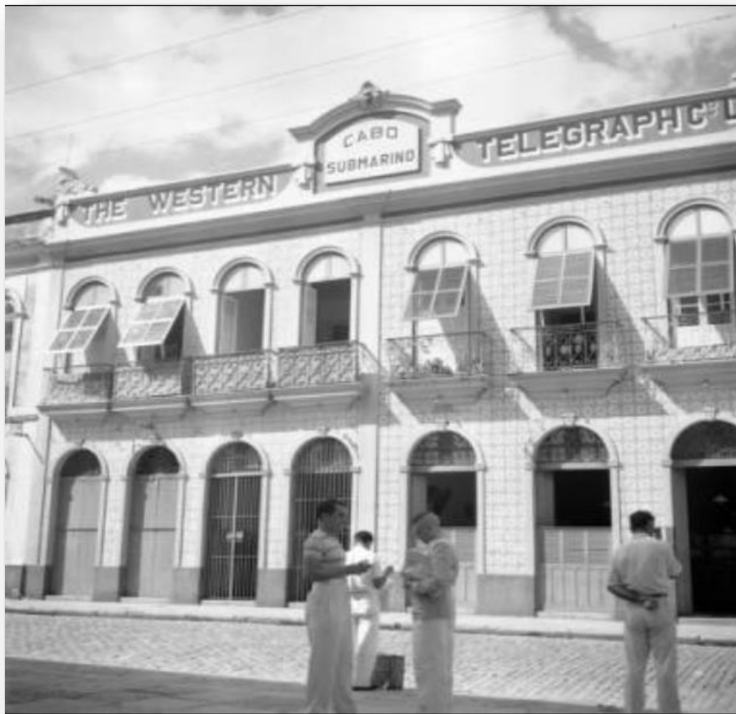
Figura 53: The Western Telegraph Company na Rua Nova do Imperador nº 73 com Tv. das Mercês.
