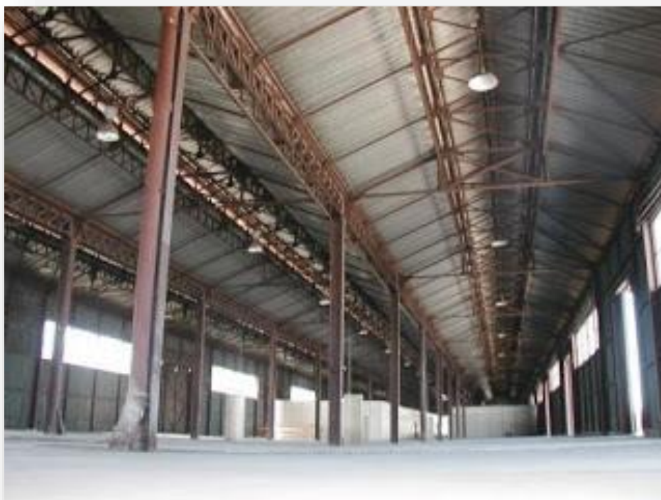
Figura 124 - Vista interna da cobertura do Armazém
