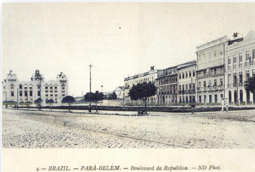
Figura 152 - Vista da quadra 08 do Boulevard da República e os sobrados
