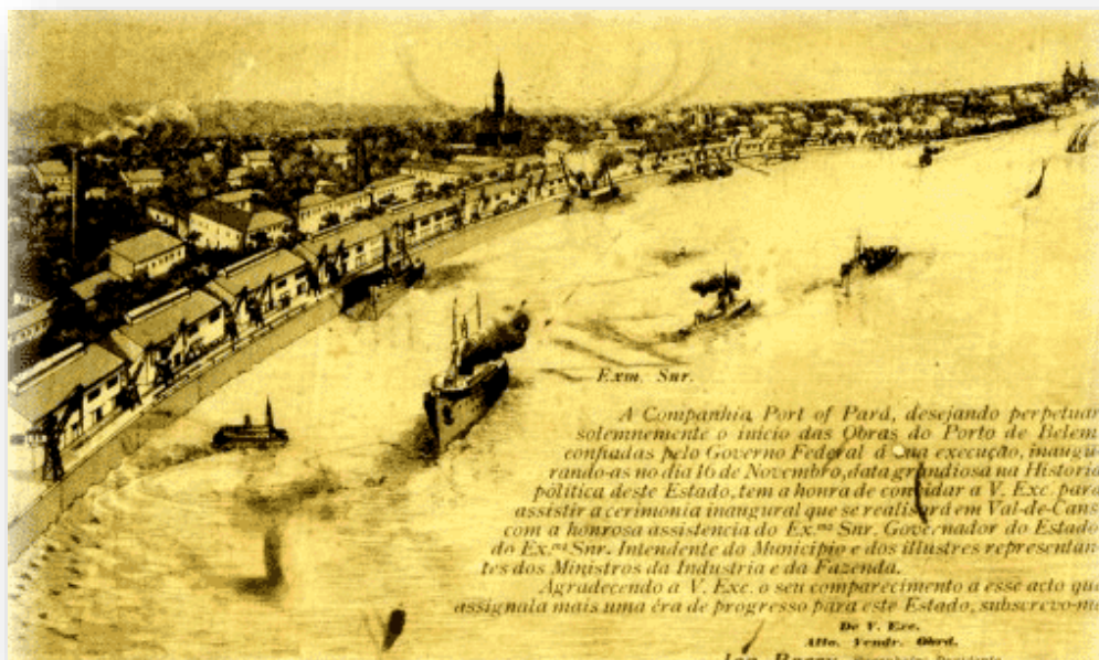
Figura 83: Convite para a solenidade do início das obras do Porto de Belém
