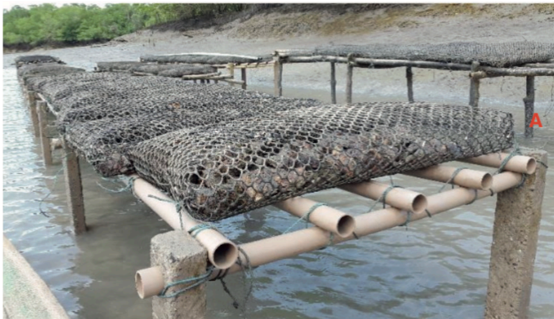
Figura 9. Estruturas com pernas de concreto em substituição às pernas feitas de bambu. Fonte: Autora, 2016.
