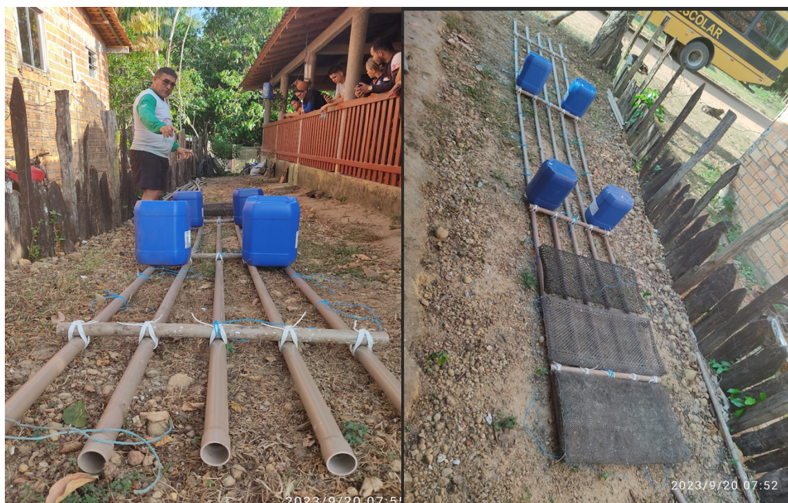
Figuras 10 e 11. Senhor Miguel mostrando como é realizada a construção da mesa da flutuante. Fonte: Labpexca, 2023.
