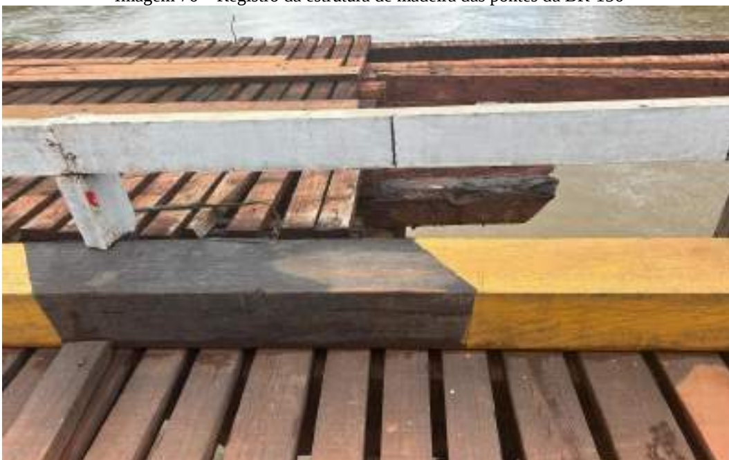
Imagem 76 – Registro da estrutura de madeira das pontes da BR-156
