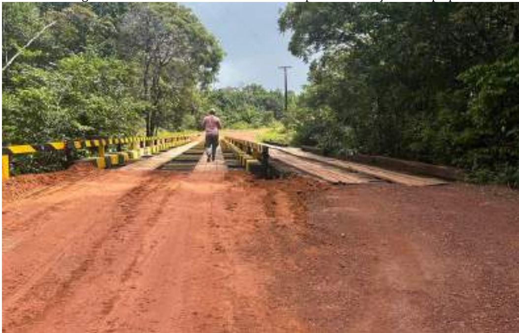
Imagem 75 – Ponte de madeira na BR-156 no perímetro Calçoene-Oiapoque
