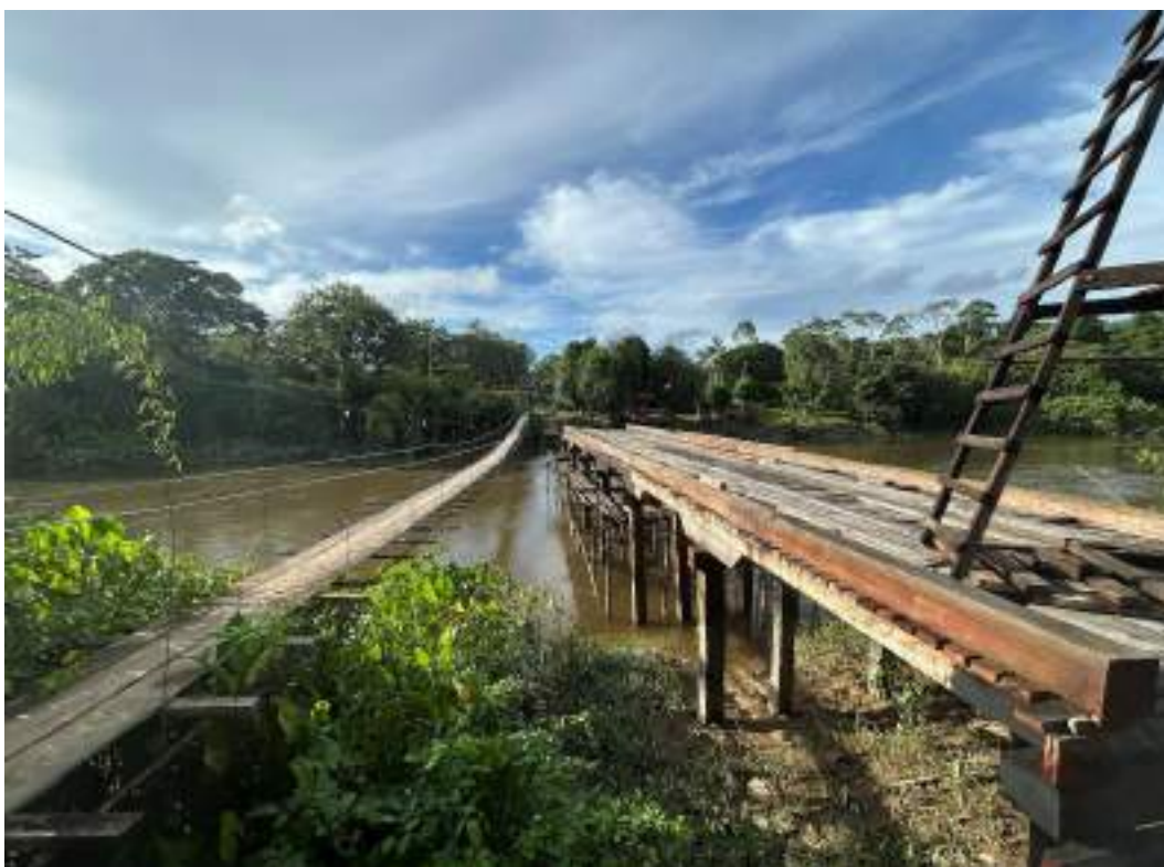
Imagem 61 – Ponte de corda e vestígios da construção da ponte de madeira para dar acesso a vila do Cunani
