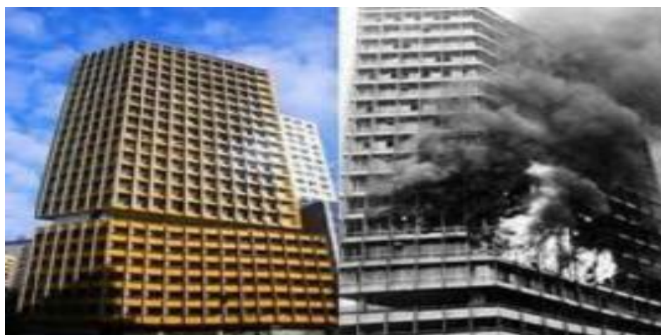
Figura 2 – Incêndio no Edifício Joelma
