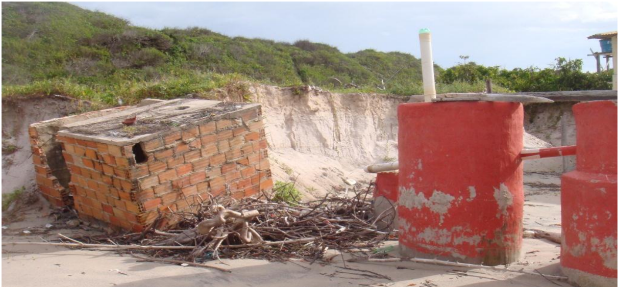
Figura 3: Presença de entulhos na praia do Atalaia. Fonte: SOUZA (maio de 2012).
