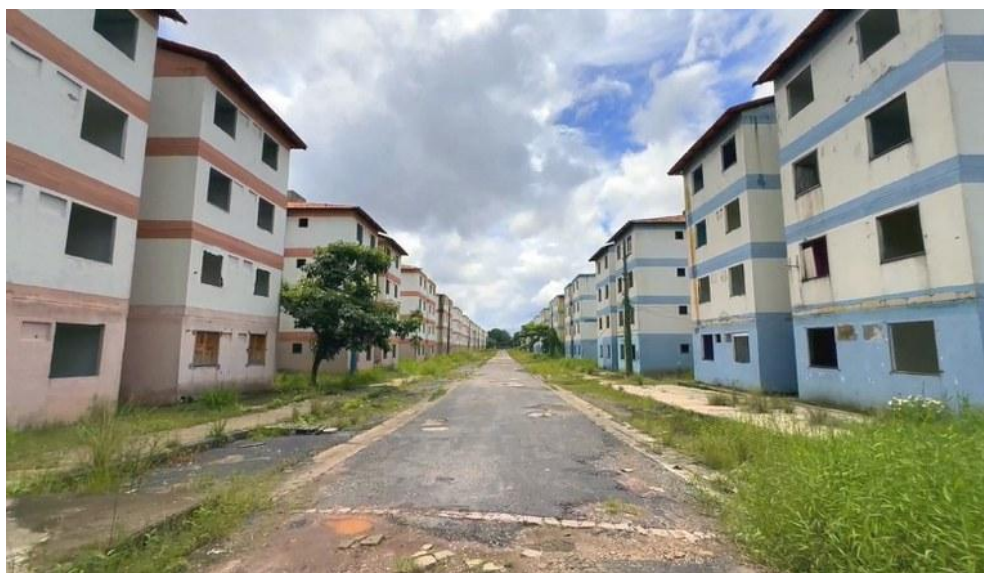
Imagem 1 – Empreendimento Viver Pratinha durante a paralisação das obras.
