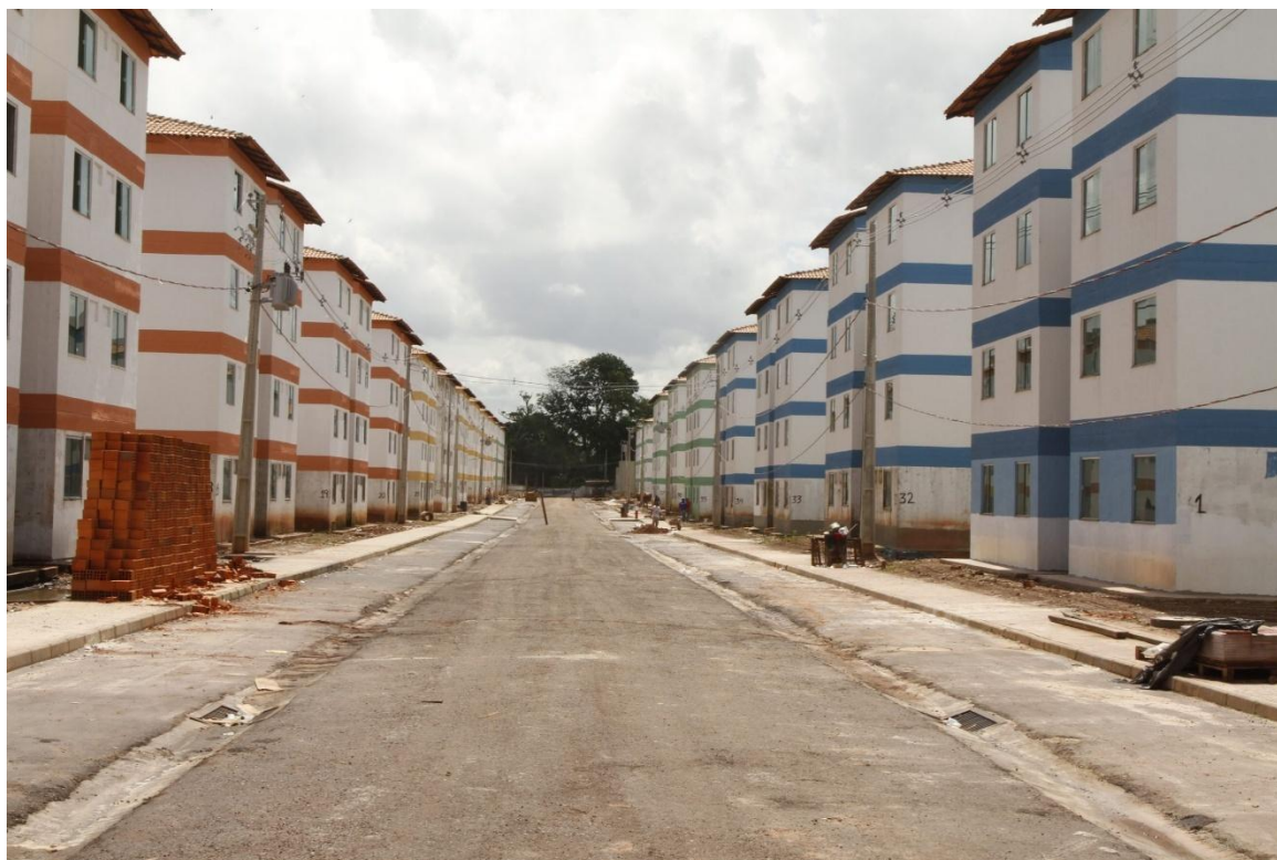
Imagem 2 – Empreendimento Viver Pratinha durante a retomada das obras.
