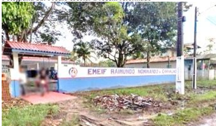
Fotografia 32: Prédio escolar 2 recém reformado
