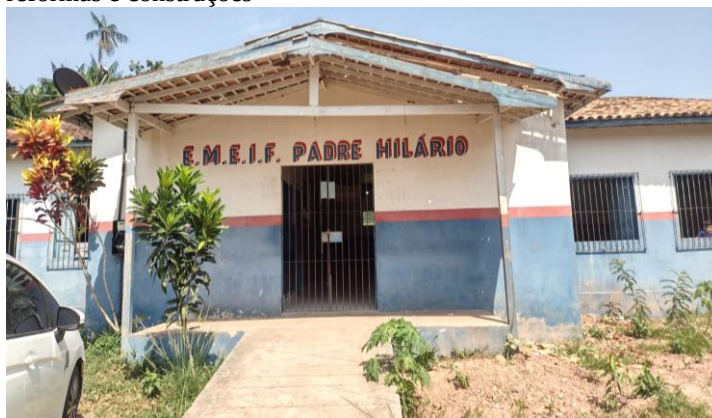
Fotografia 34: Prédio escolar 2 que apresenta necessidades de reformas e construções
