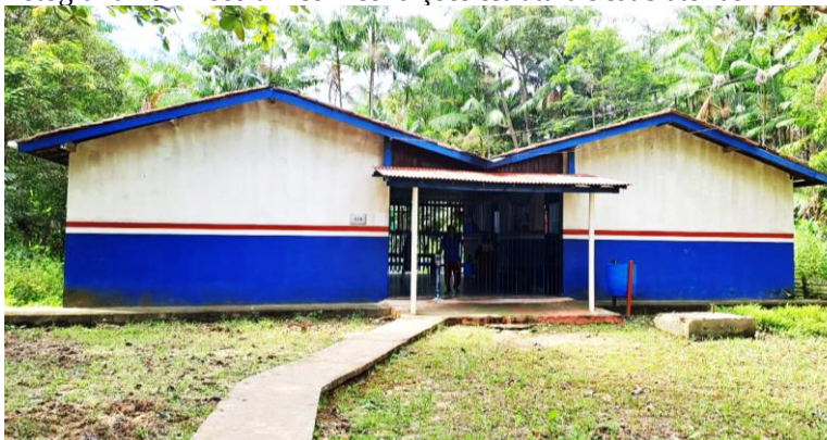
Fotografia 26 – Escola 1 com condições estruturais satisfatórias
