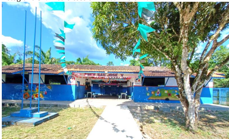
Fotografia 31: Prédio escolar 1 recém reformado
