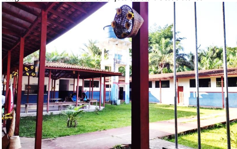
Fotografia 28 - Escola 3 com condições estruturais satisfatórias
