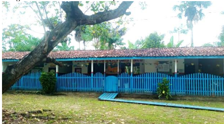
Fotografia 27 – Escola 2 com condições estruturais satisfatórias
