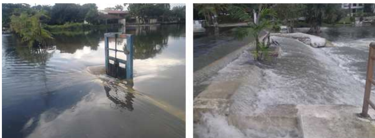
Figura 198 - Transbordamento da barragem utilizada no controle do volume no Lago.
