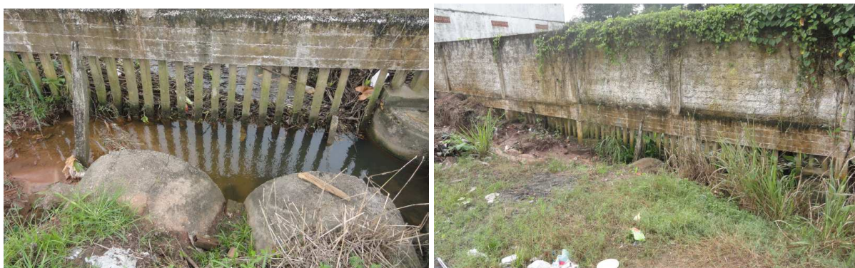
Figura 155 – Muro que delimita a propriedade da “fazenda”.
