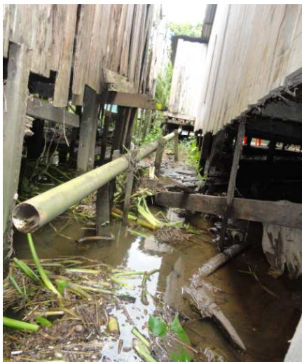
Figura 140 – Lançamento de esgoto diretamente no rio Maguari-Açu.
