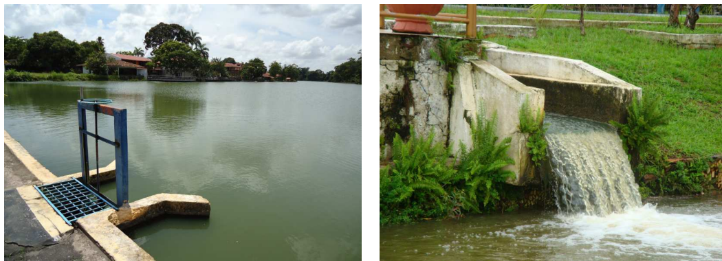
Figura 164 – Uma das comportas e uma das saídas de água do lado 1 para o lago 2
