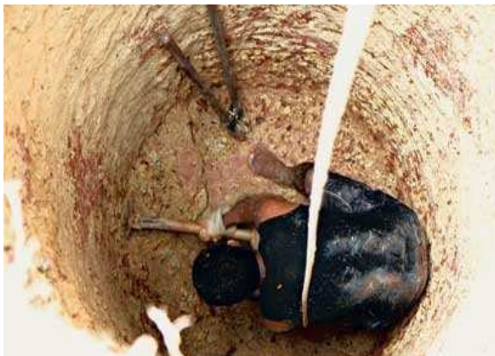
Figura 114 – Escavação manual de poços na RMB. Fonte: 900 mil....(2012).
