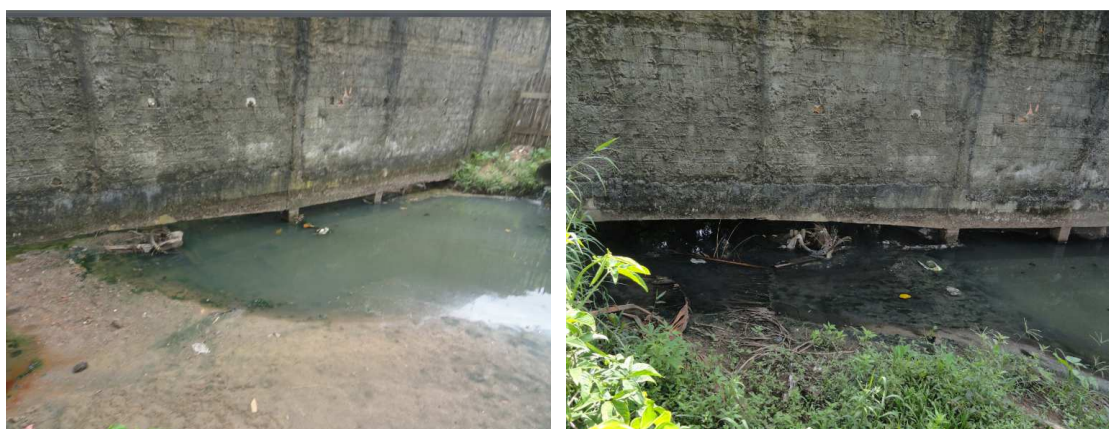
Figura 147 – Muro em dois períodos diferentes com indicação de assoreamento.
