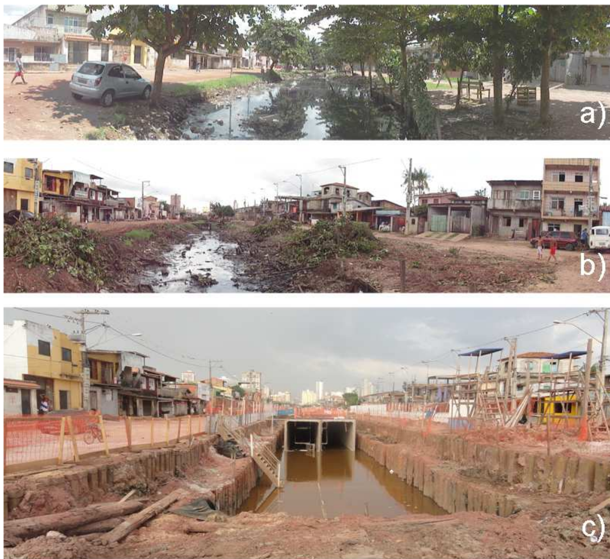
Figura 67 – a) condição do canal Caripunas antes da intervenção, b) condição do início da obra, c) construção das galerias.
