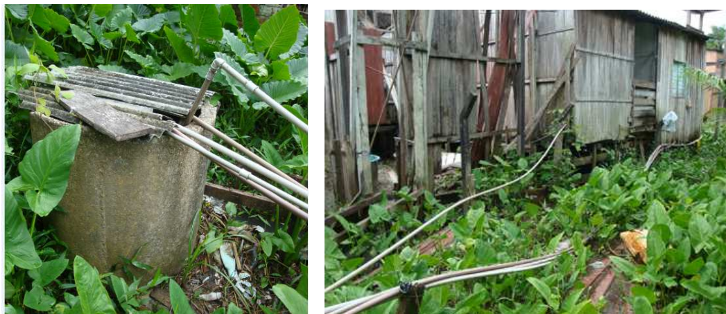
Figura 108 - Poço amazonas utilizado para abastecer residências localizadas sobre o rio.
