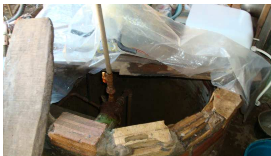
Figura 101 - Poço raso tipo amazonas para uso residencial.
