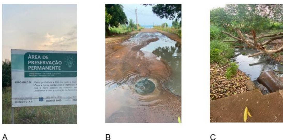
Figura 71: Esgoto adentrando em Área de Preservação Permanente.
