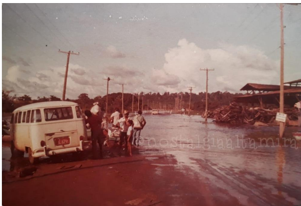
Figura 24: Inundação Ocasionada pela Enchente em Altamira registrada na década de 80.
