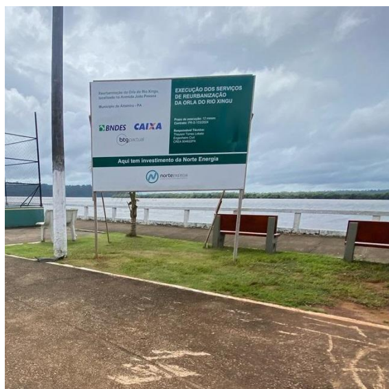
Figura 64: Placa de obra da Norte Energia abordando os serviços de reurbanização da Orla do Rio Xingu
