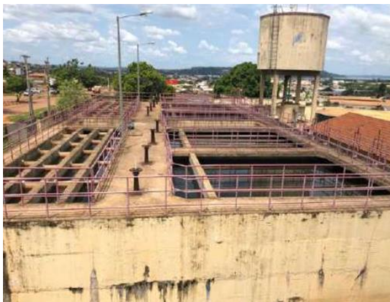
Figura 23: Estrutura da Antiga Estação de Tratamento e do Reservatório da COSAMPA.
