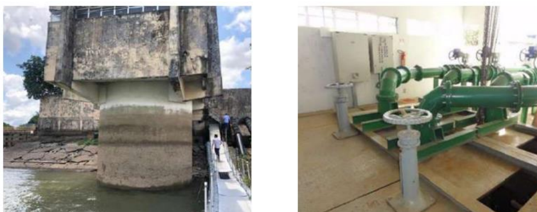
Figura 22: Estrutura antiga da Capacitação de água da COSAMPA.
