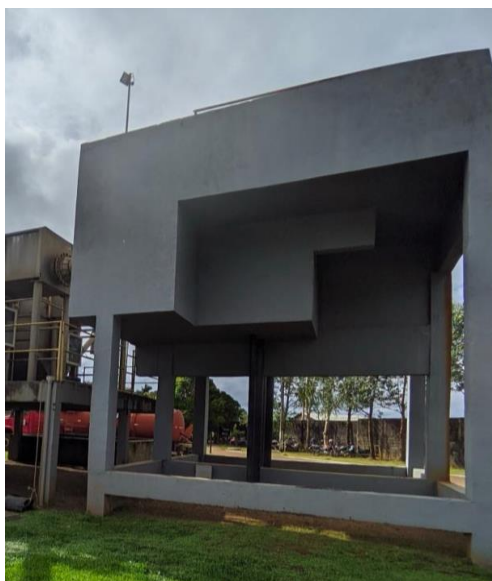
Figura 45: Caixa de entrada e tratamento preliminar.
