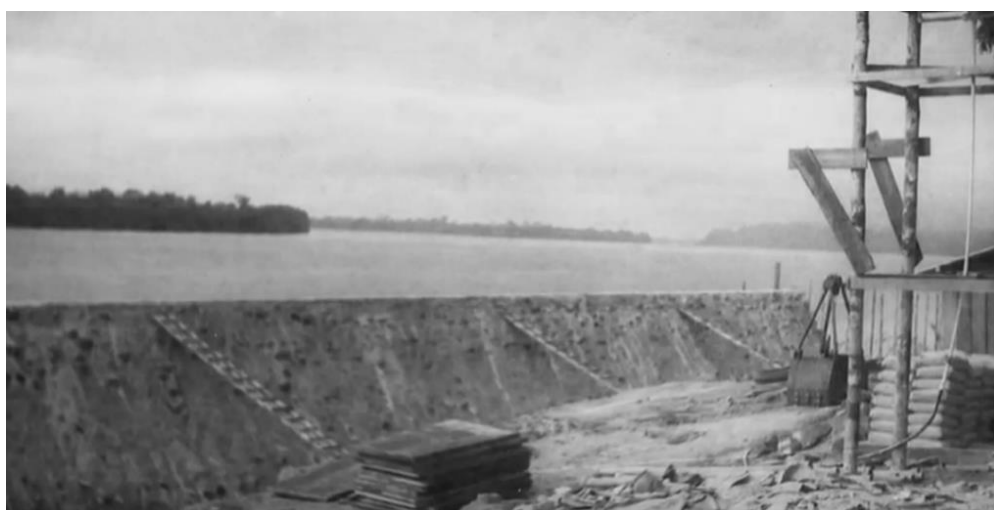
Figura 20: Revitalização da Orla do Cais de Altamira e construção da Rede de esgotamento e captação de águas pluviais.
