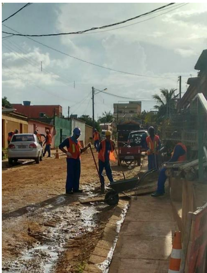
Figura 54: Processo de Interligação de Residências à Rede de Saneamento em Altamira - Pa.
