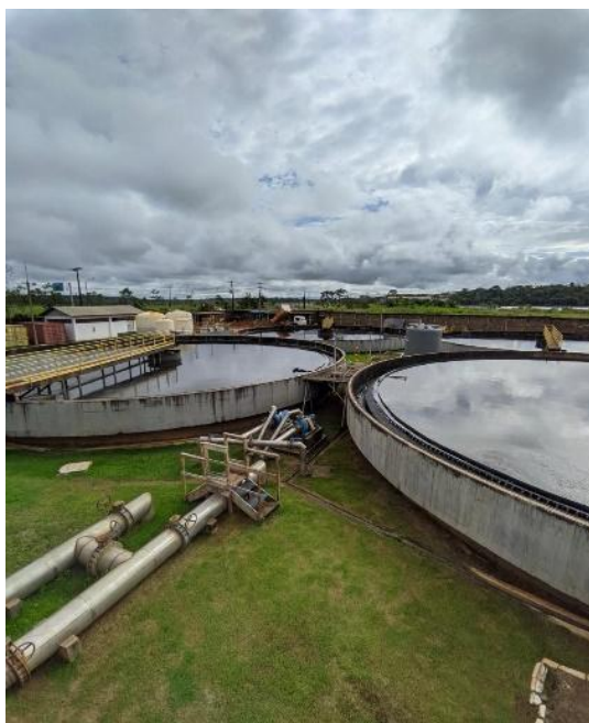
Figura 49: Vista dos Decantadores.
