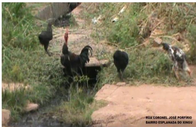
Figura 33: Esgoto despejado na via pública de Altamira - Pa.
