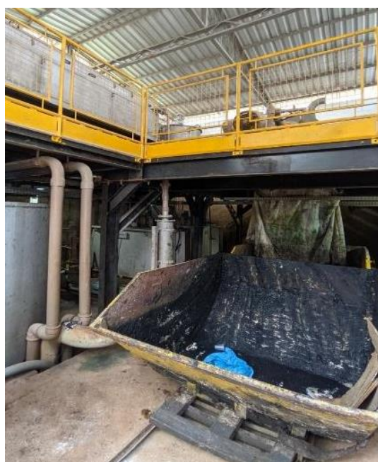
Figura 50: Tanque de Lodo e casa de Lodo.
