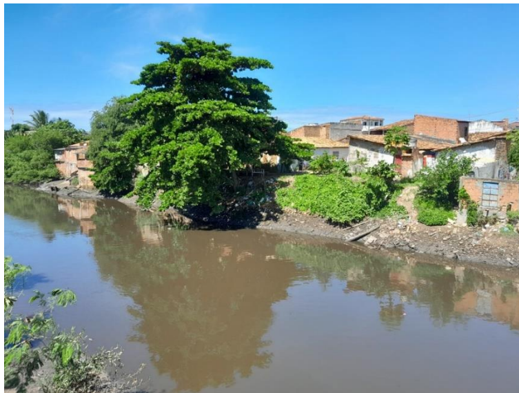
Figura 12 - Crescimento desordenado sobre o mangue do Bairro São Conrado. Fonte: Arquivo do autor, 2024.
