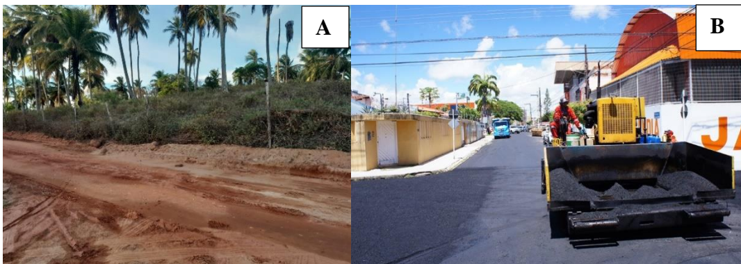
Figura 61 - Foto A: Falta de calçamento público na Zona de Expansão de Aracaju (2024). Foto B: Recapeamento asfáltico no Bairro Salgado Filho (2021).
