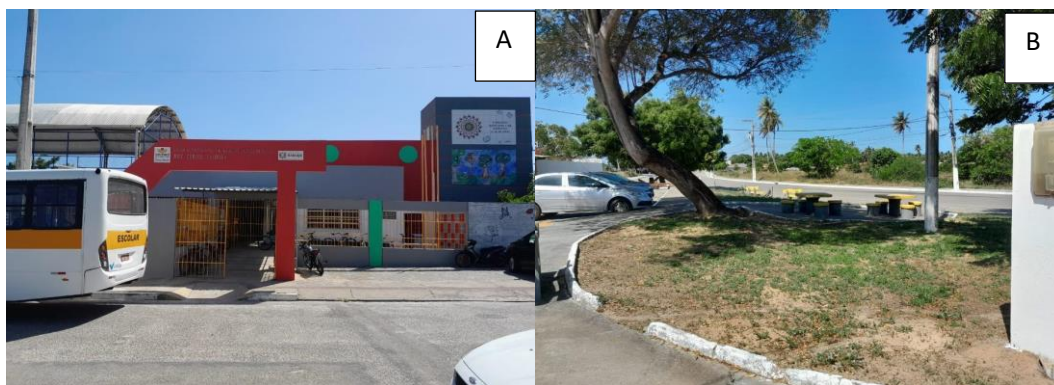
Figura 39 - Foto A: Fachada da EMEF José Carlos Teixeira, Bairro Mosqueiro. Foto B: Praça defronte à escola. Foto: Próprio autor, 2023.
