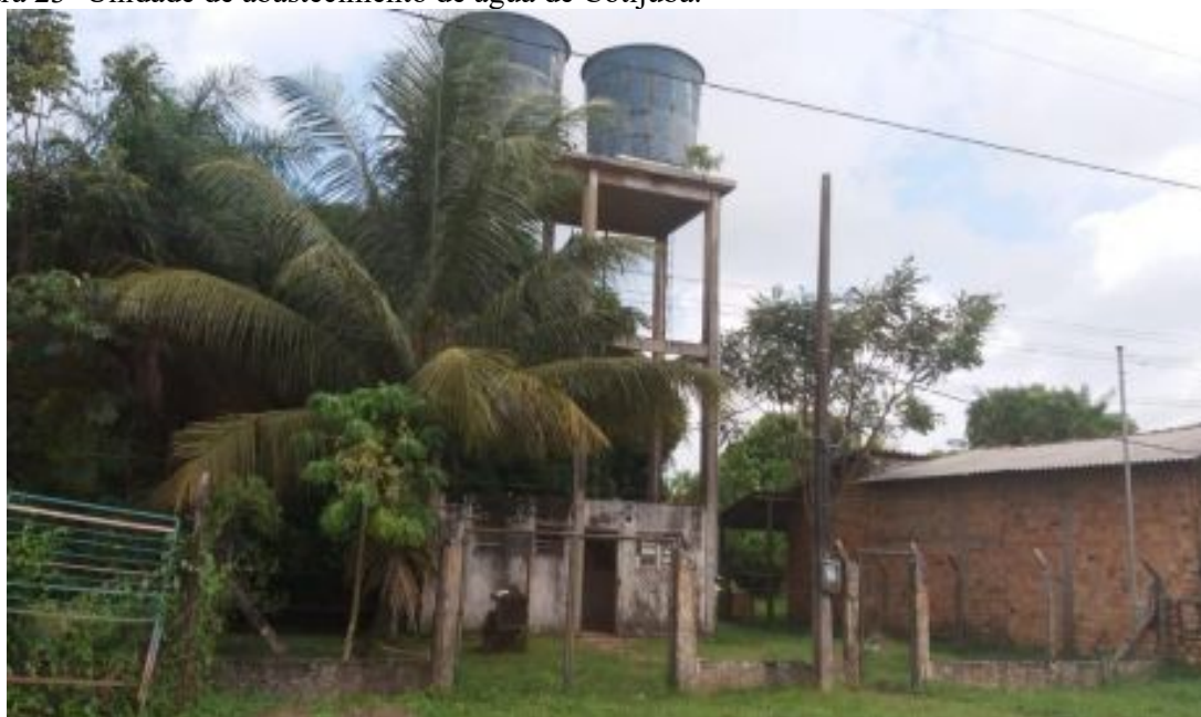
Figura 23- Unidade de abastecimento de água de Cotijuba.
