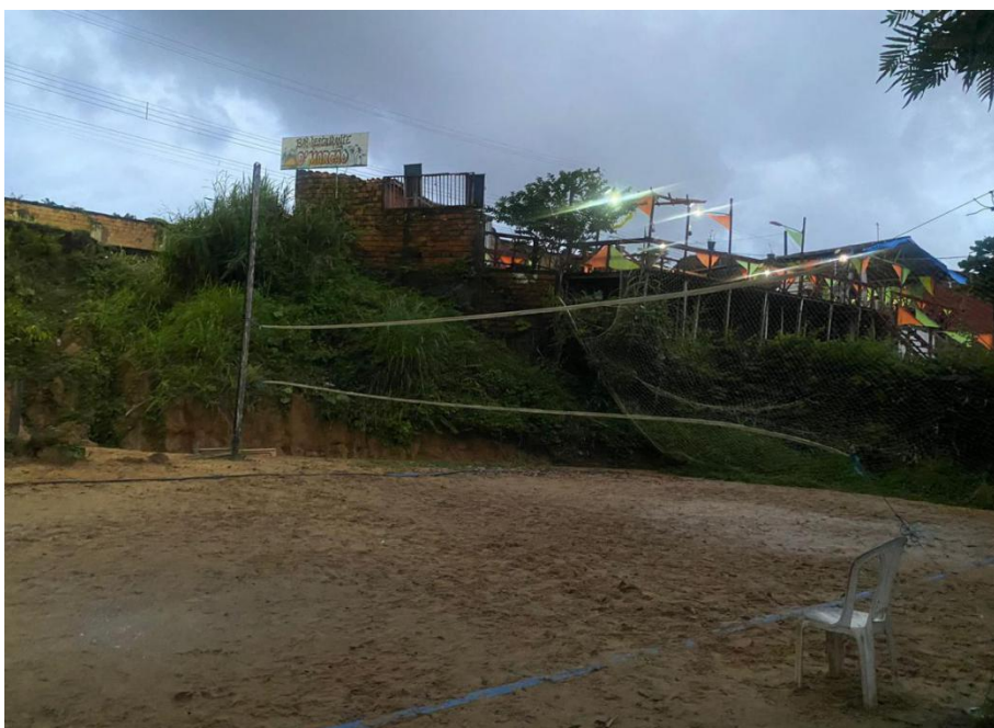
Imagem 03- Estabelecimento com alto risco de erosão.
