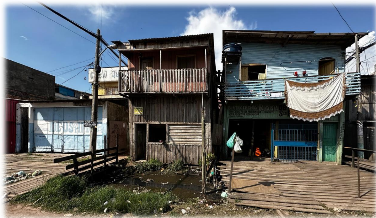
Figura 3 – Moradias localizadas na Av. Bernardo Sayão, bairro Jurunas
