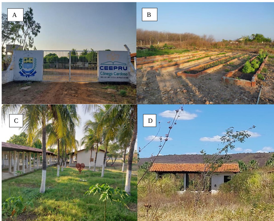
Figura 16 - Entrada do CEEPRU Cônego Cardoso (A); Horta do CEEPRU (B); divisória do bloco da diretoria e salas de aulas (C); aviários tomados pela vegetação e em estado de abandono (D). Fonte: Autor (2023)
