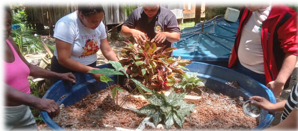
Figura H3 – Implantação do jardim filtrante, evidenciando o leito filtrante, a tubulação interna e as espécies vegetais utilizadas no tratamento complementar do efluente.
