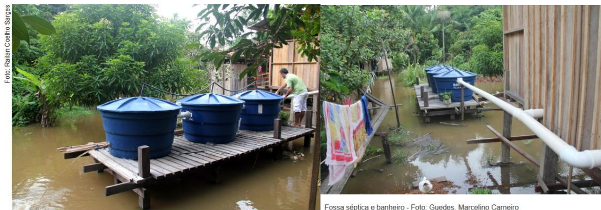
Figura A3 - Fossa séptica biodigestora instalada na Ilha das Cinzas – Gurupá, PA (4)
