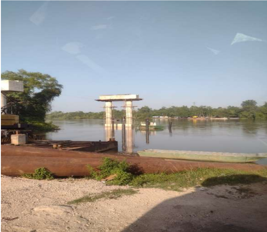
Imagem 08: Construção da ponte que liga a Ilha ao Continente, 2024.
