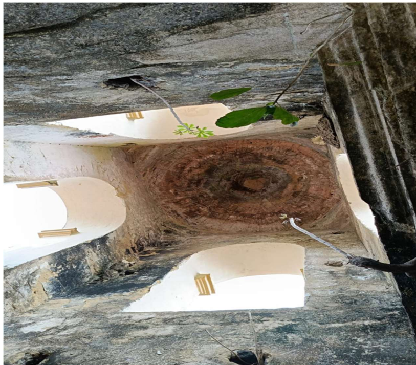
Imagem 06: Foto interna (Torre Sineira da Igreja).
