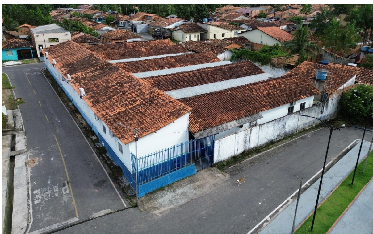
Figura 15 – Fachada da EMEF Pedro Chaves. A imagem revela ausência de identificação institucional na fachada e a precariedade da pintura, indicando sinais de abandono estrutural. O portão azul visível na imagem é o único ponto de entrada e saída da comunidade escolar.
