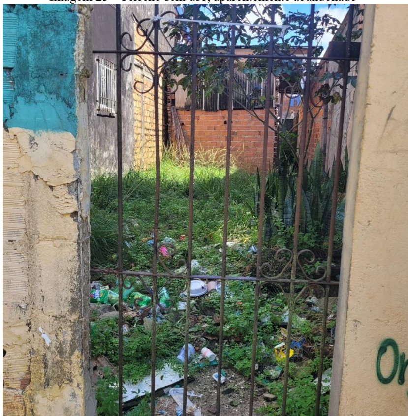
Imagem 25 - Terreno sem uso, aparentemente abandonado
