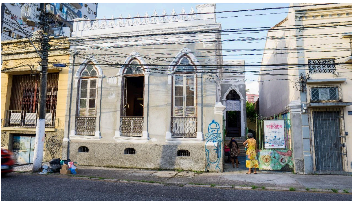
Figura 8 – Fachada frontal do Casarão do Boneco
