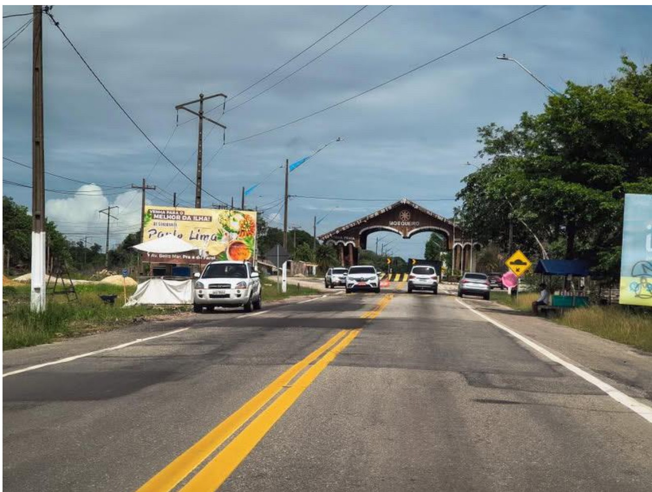
Figura 3: PA-391, acesso a Ilha de Mosqueiro. Fonte: (Autor, 2024)
