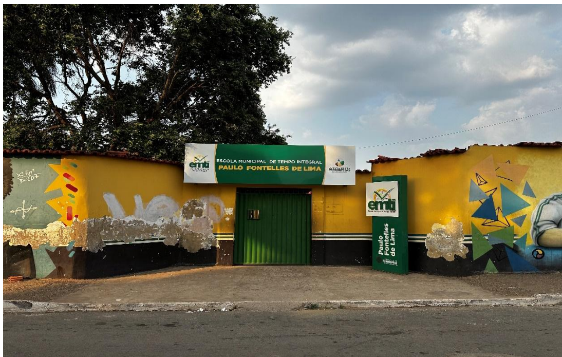
Figura 1 - Foto da fachada da escola
