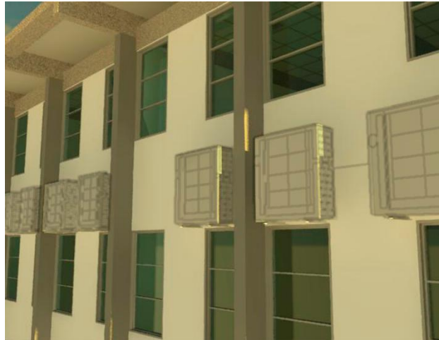
Figura 4.31 - Fachada Norte do prédio com aparelhos padronizados.
