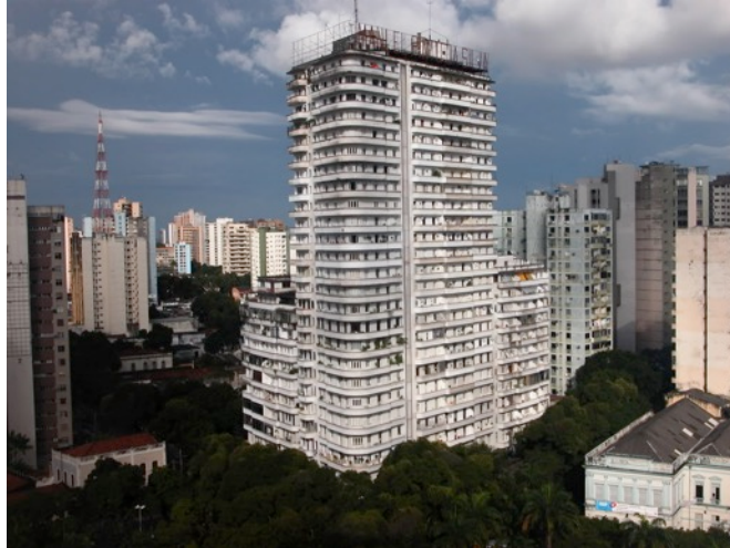
Fotografia 3 – Edifício Manoel Pinto da Silva
