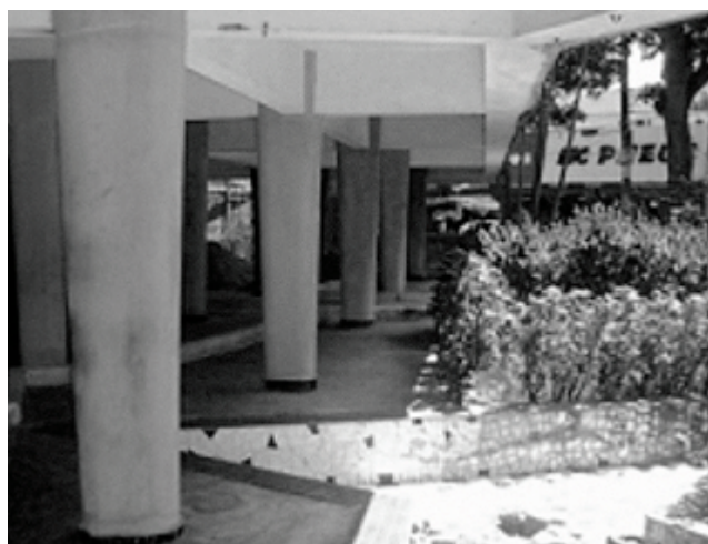
Fotografia 1 – Detalhe dos pilotis e do piso em mosaico de azulejos no edifício “São Miguel”
