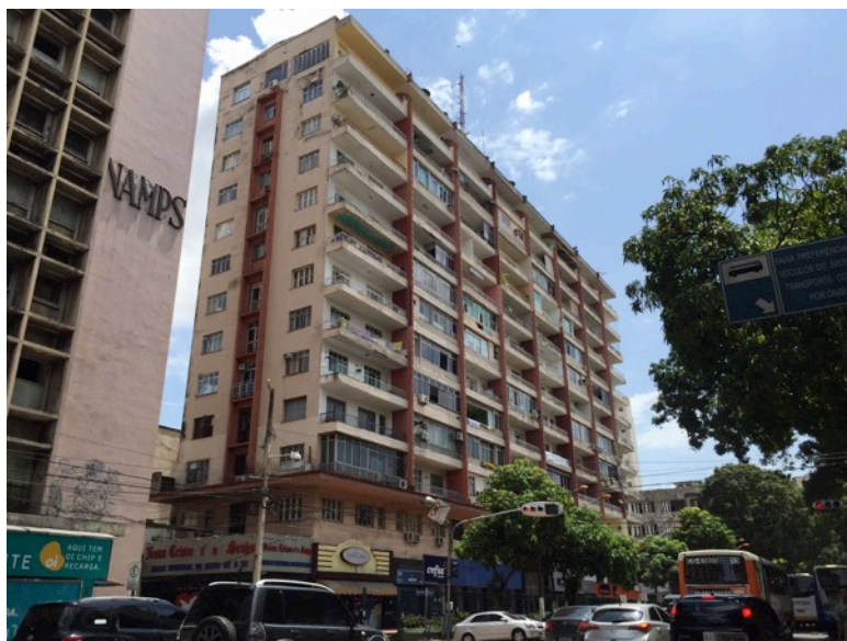
Fotografia 2 – Edifício Palácio do Rádio, projeto de Judah Levy
