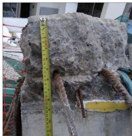
b) Detalhe de uma das ligações laje-pilar
