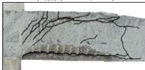
a) Ruptura por delaminação (Hassan, 2015)
