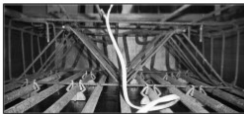
Figura 2.14 – Armadura treliçada pré-fabricada (Ferreira et al. , 2016)
