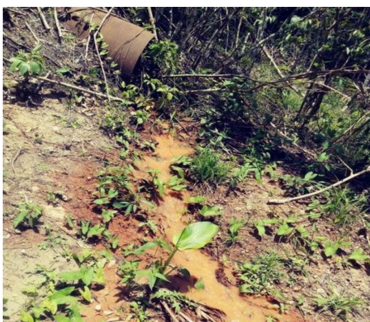
Tubulação clandestina da empresa Hydro, na mata-2018
