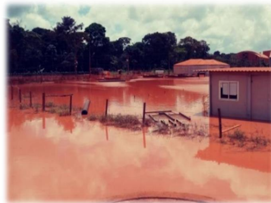
Derramamento de lama vermelha nas instalações da HYDRO -2018
