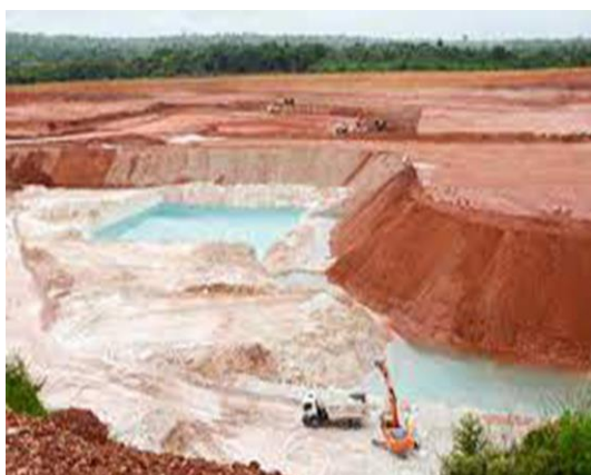
Vazamento de Caulim da bacia de rejeitos da Ymeres -2016
