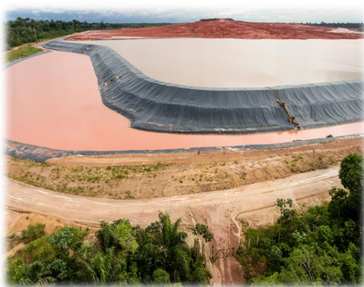
Derramamento de lama vermelha nas instalações da HYDRO -2018
