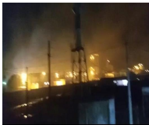
Incêndio em galpões da Ymeris, com liberação de fumaça tóxica de hidrossulfito de sódio em vila do conde -2021
