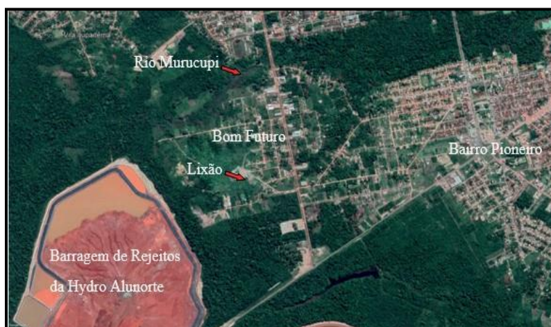
Figura 19 : Localização da comunidade Bom Futuro às proximidades da barragem de Rejeitos.
