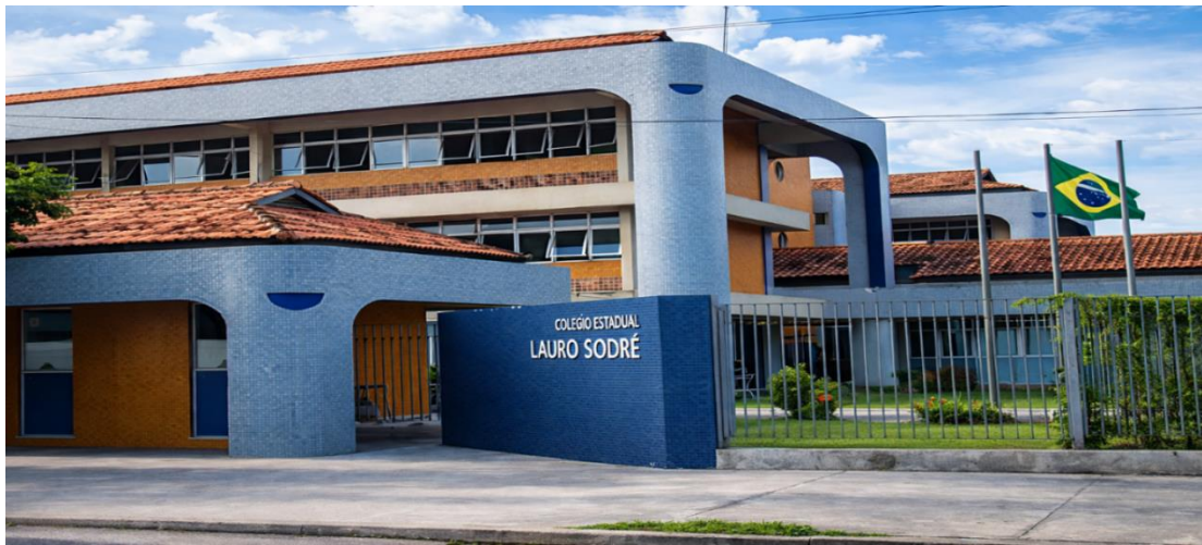
Figura 2 - Frente da escola Lauro Sodré, Belém-Pará
