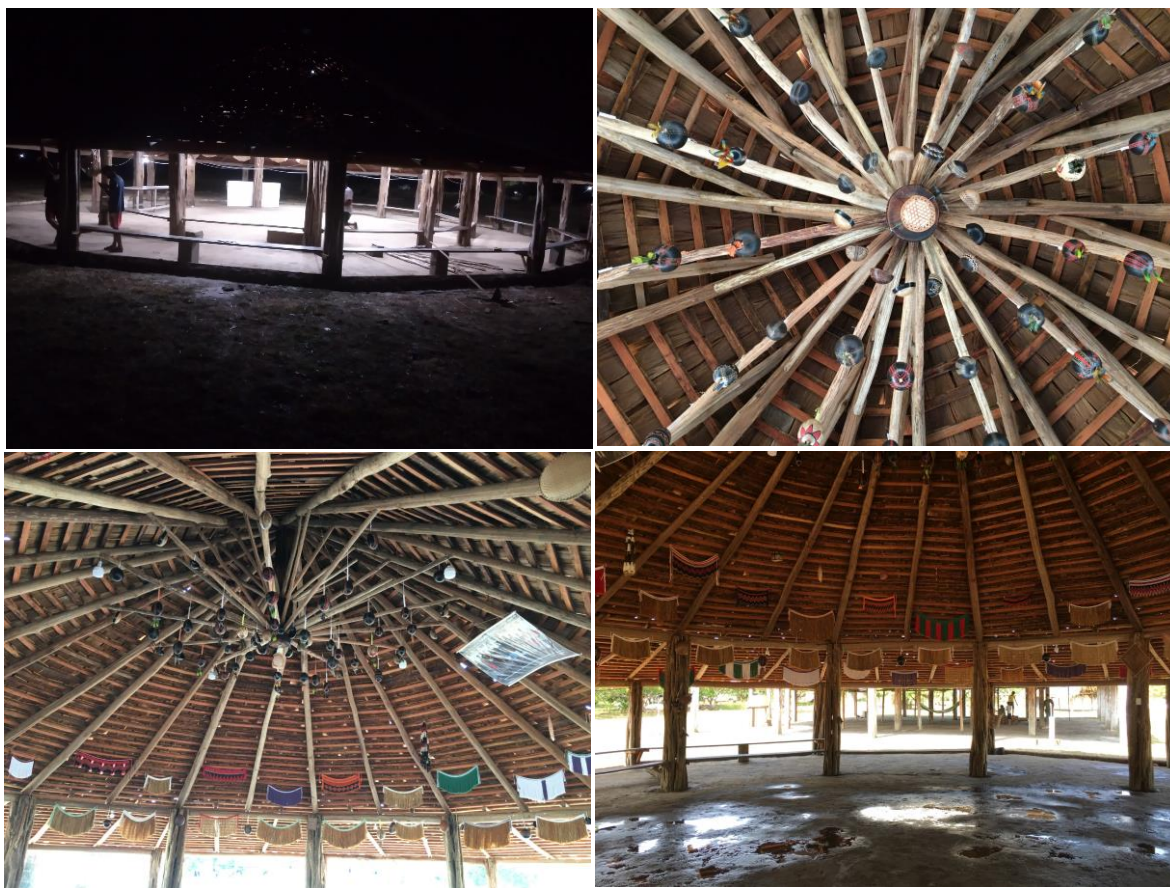
Imagem 11 - Parte interna da ramada.
