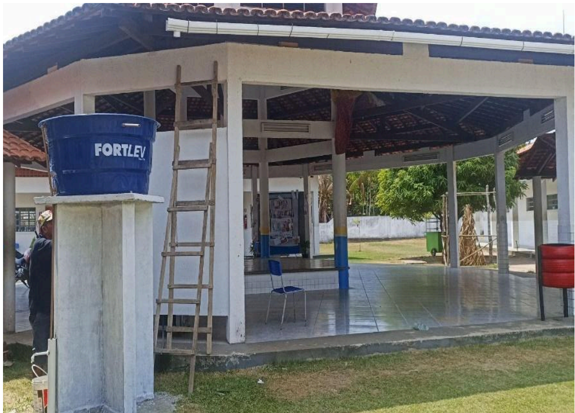
Figura 14 - Instalação da base e da calha que receberá as águas pluviais.
