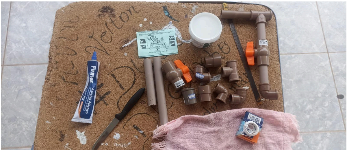
Figura 10 - Preparação dos utensílios para instalação do clorador.
