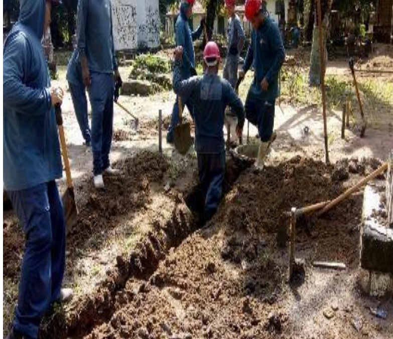
Figura 25–Trabalhadores preparando o solo para recebimento hidráulico
