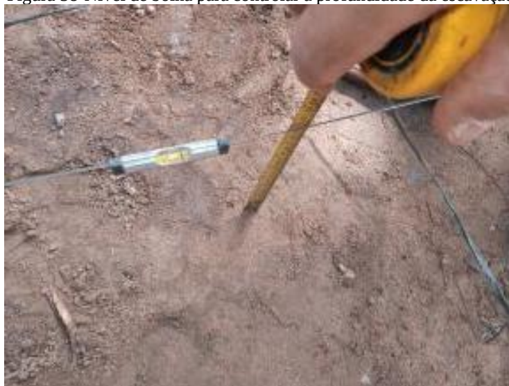
Figura 38-Nível de bolha para controlar a profundidade da escavação
