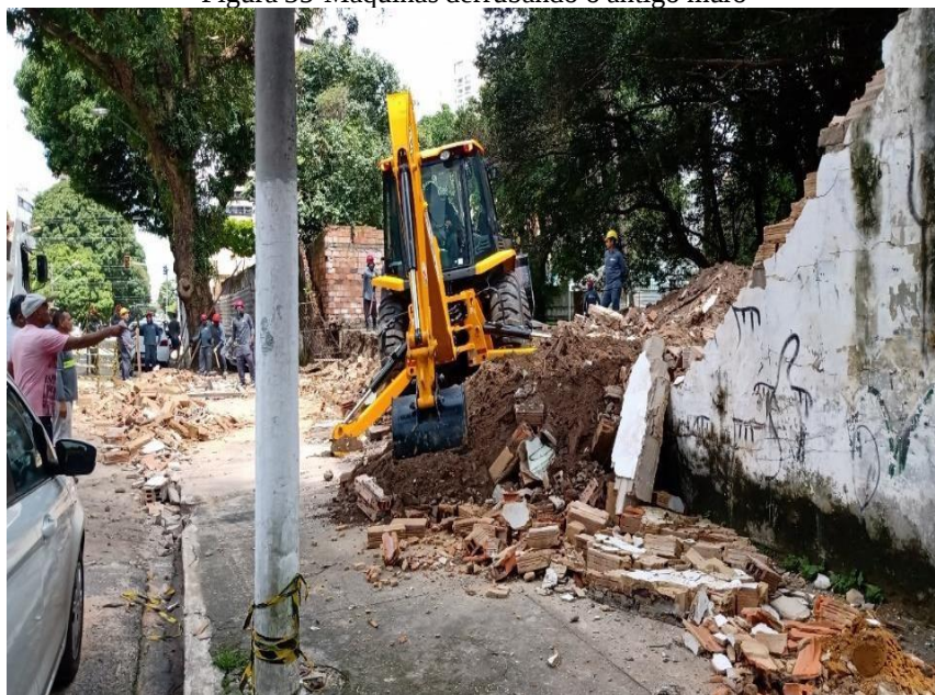
Figura 35-Máquinas derrubando o antigo muro
