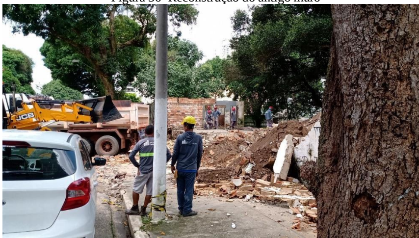
Figura 36-Reconstrução do antigo muro
