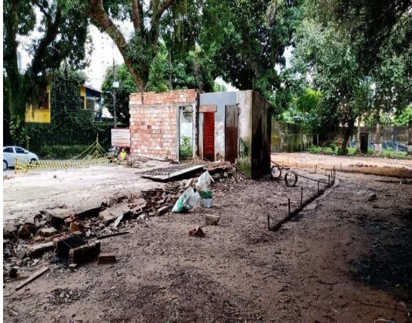
Figura 34-Antigo depósito de guardar materiais dos feirantes.
