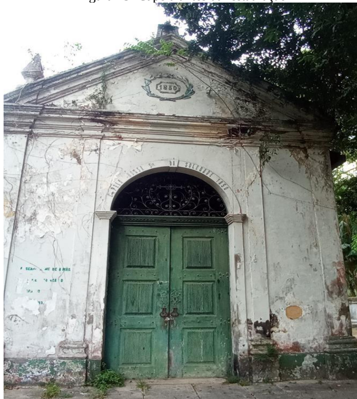
Figura 15- Capela antes da restauração
