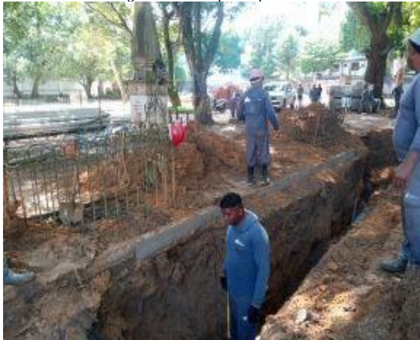
Figura 26-Construção das passarelas
