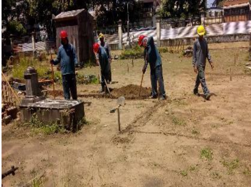
Figura 23:- Trabalhadores preparando o solo para recebimento hidráulico
