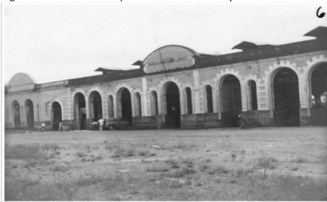
Figura 7 - Oficina de manutenção dos trens no atual município de Marituba-Pará-Brasil
