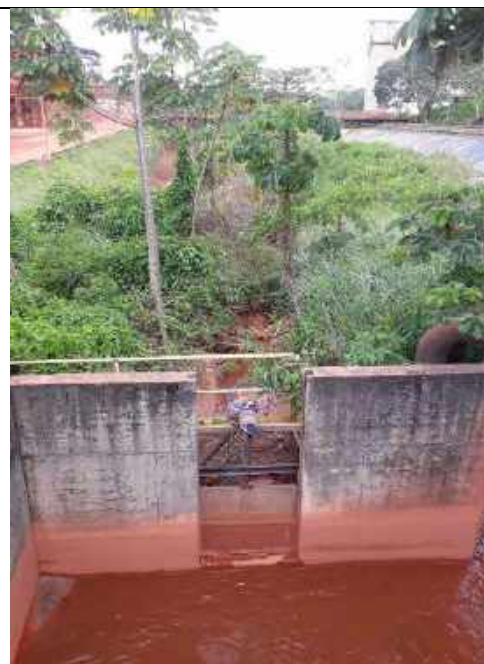
Figura 20 – Vista geral da estrutura
