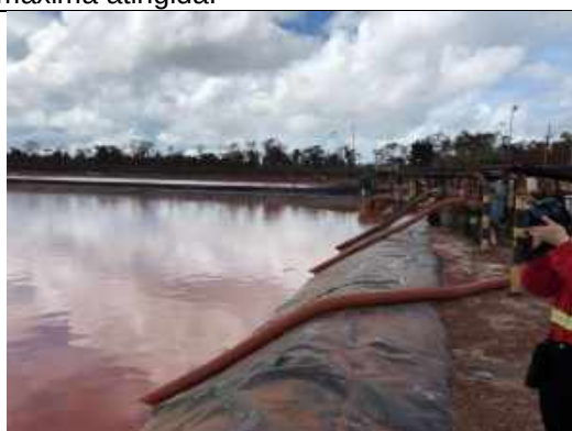
Figura 7 – Funcionários da Hydro Alunorte drenam o conteúdo da Bacia de rejeitos (Depósitos de Resíduos Sólidos - DRS 1).
