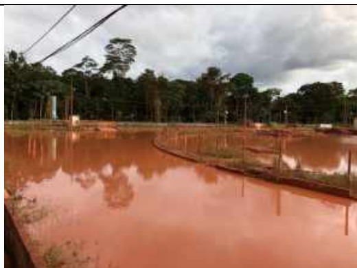
Figura 11 – Vala de segurança que circunda a Bacia de rejeitos (Depósitos de Resíduos Sólidos - DRS 1), também inundada.
