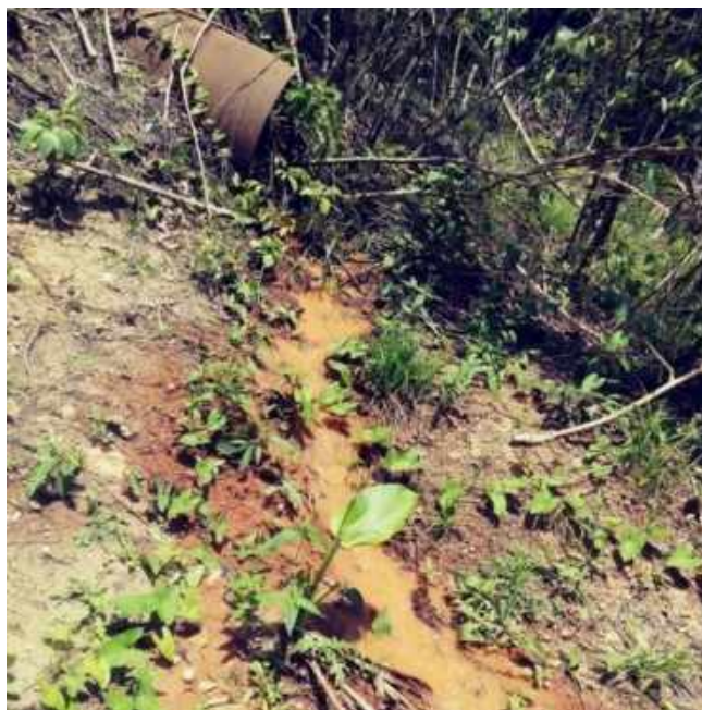
Figura 1 – “Tubo Clandestino” verificado em vistoria.
