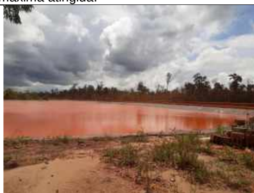
Figura 8 – Bacia de rejeitos (Depósitos de Resíduos Sólidos - DRS 1) com capacidade máxima atingida.
