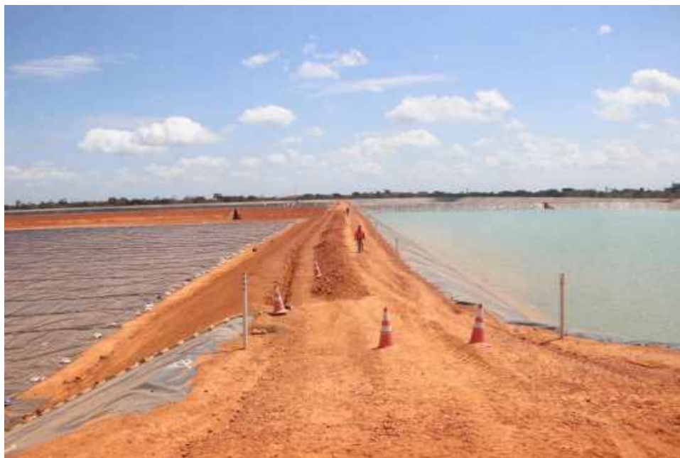
Imagem 60: Imagens de Bacias de Rejeitos da empresa Mineração Paragominas, que têm a finalidade de reter os resíduos sólidos e água dos processos de beneficiamento de minério. Fonte: Carlos Boução
