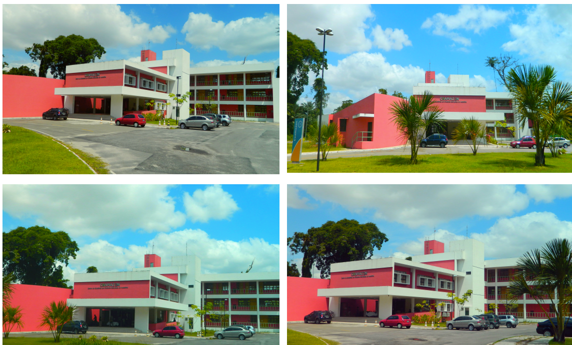
Figura 4 – Imagens do prédio do CEAMAZON
