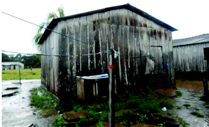
Figura 09: Construção de casas na TI Arara
