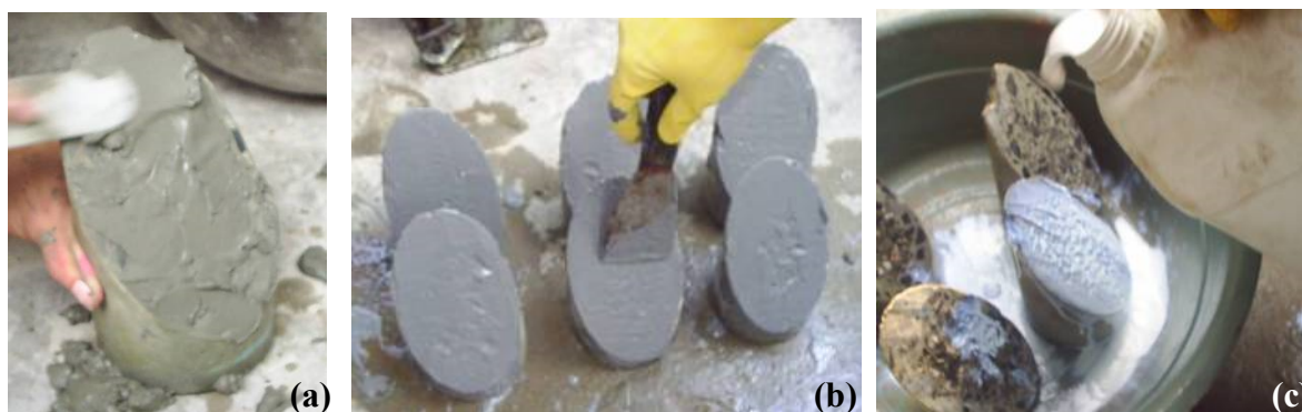
figura 20 – Diversos modos de aplicação dos adesivos utilizados na etapa de ponte de aderência (FOTO: José Rodrigo Santana Pinho).
