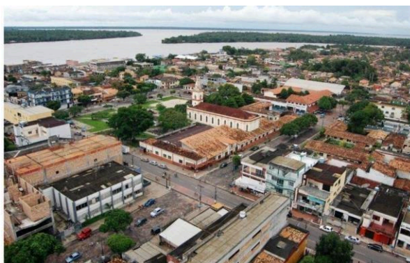
Mapa 4 - Foto aérea do rio em frente a orla da cidade. Destaco, na parte central, a Igreja de Nossa Senhora da Conceição, padroeira da cidade. Fonte: https://abaetetuba.pa.gov.br/wpcontent/uploads/2025/01/PMS_ABAETETUBA_MS_2017_DIAG_01.pdf
