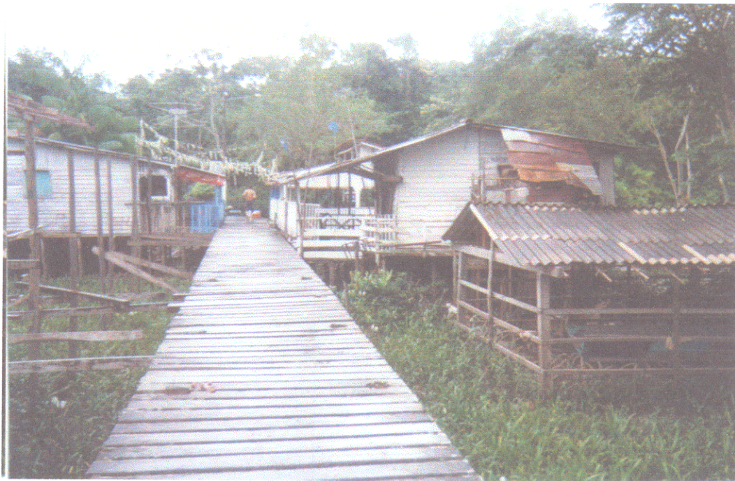
Figura 29. Situação as margens do igarapé Tamanduá - residências do tipo palafita , criações de animais (canto direito da foto) essa área é totalmente inundada em marés altas (sizígia).
