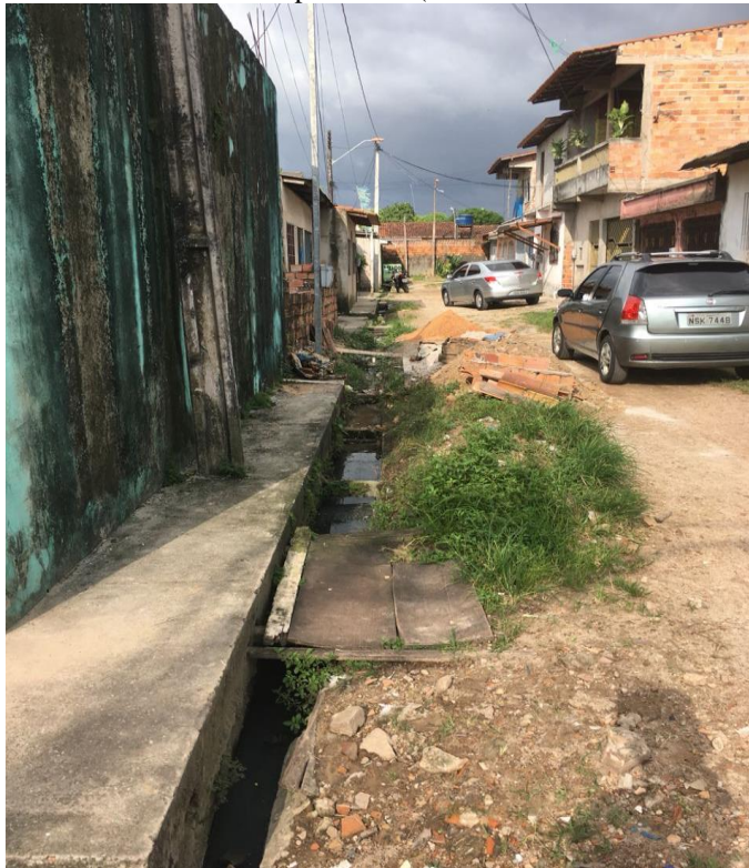
Figura 23 – Dificuldade de acesso para PNE (Portadores de Necessidades Especiais)
