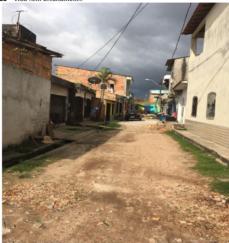
Figura 22 – Rua sem asfaltamento
