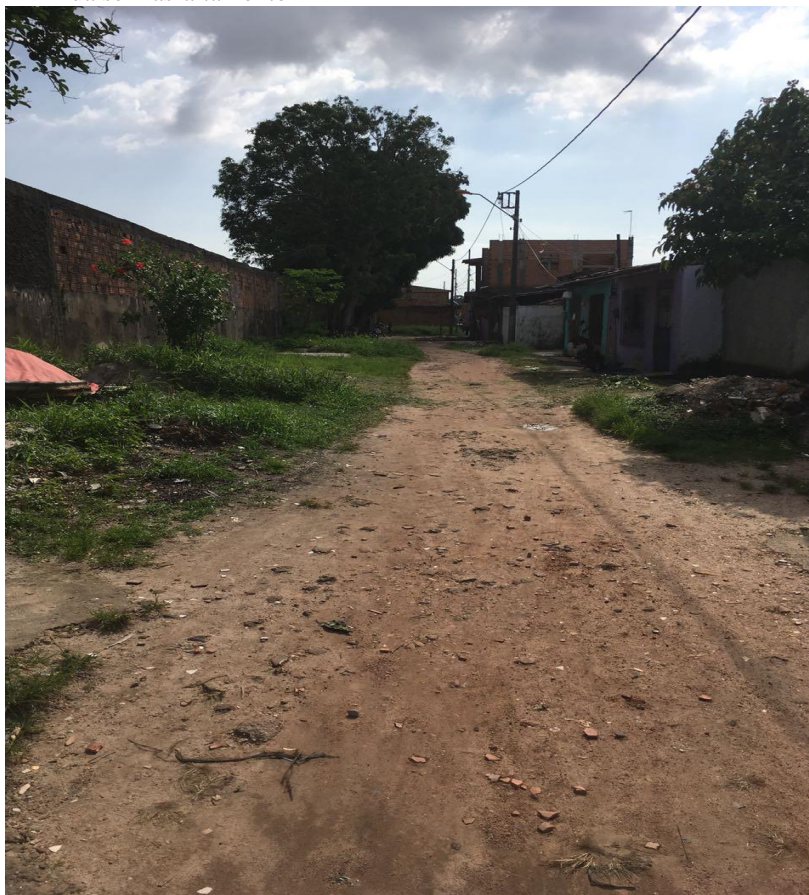
Figura 21 – Rua sem asfaltamento
