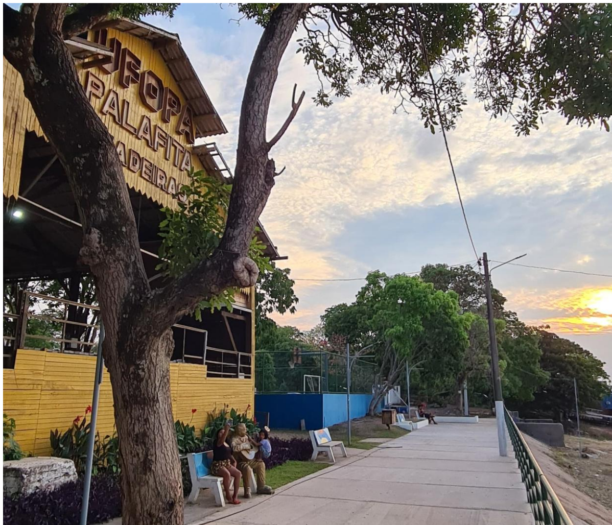
Figura 23 – UFOPA: vista parcial do “Palafita Madeirão”, espaço de convívio/recreação recém-reformado às margens do Rio Tapajós, no Campus Tapajós , em Santarém
