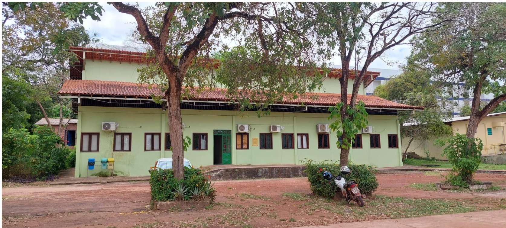
Figura 21 – UFOPA: vista parcial do interior do Campus Tapajós , em Santarém, com destaque, ao fundo, para o Laboratório de Ecologia e Comportamento Animal (LECAAn)
