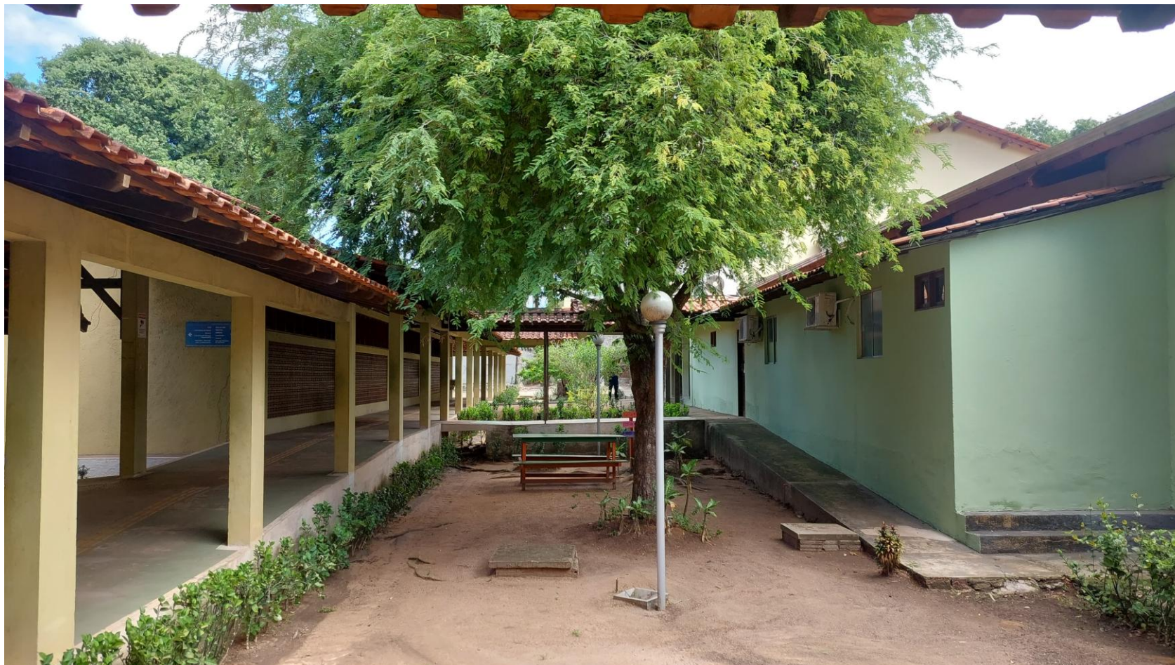
Figura 18 – UFOPA: vista parcial de um bloco de aulas (à esquerda), um laboratório de ensino (à direita) e da biblioteca (ao fundo, à direita) no Campus Rondon , em Santarém
