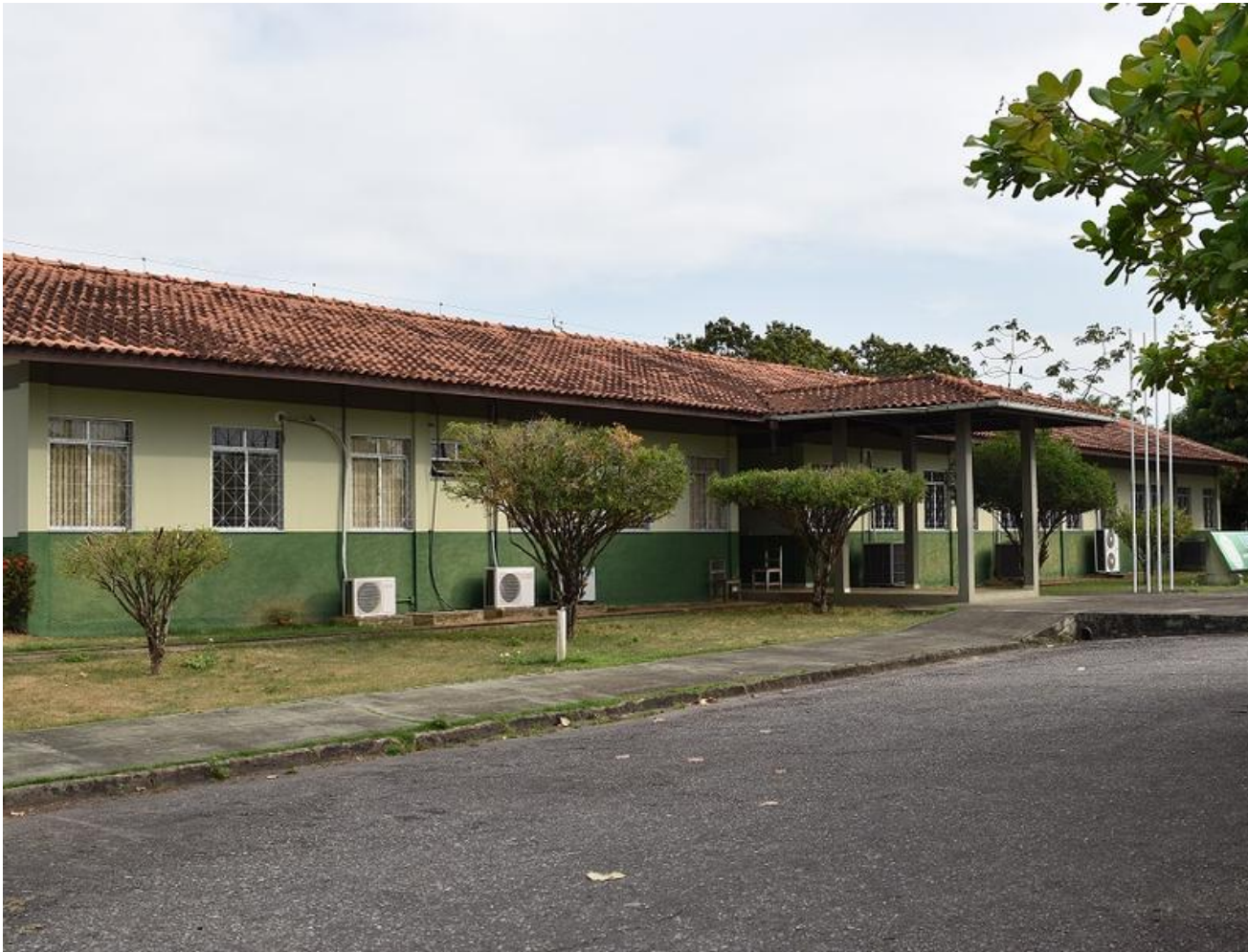
Figura 28 – UFOPA: vista parcial do Campus de Oriximiná, com estrutura aproveitada da UFPA
