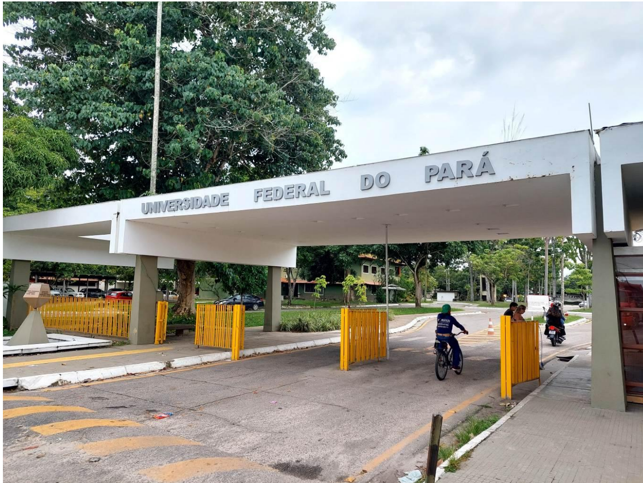
Figura 8 – UFPA: vista parcial da entrada da cidade universitária “José da Silveira Netto”, atualmente
