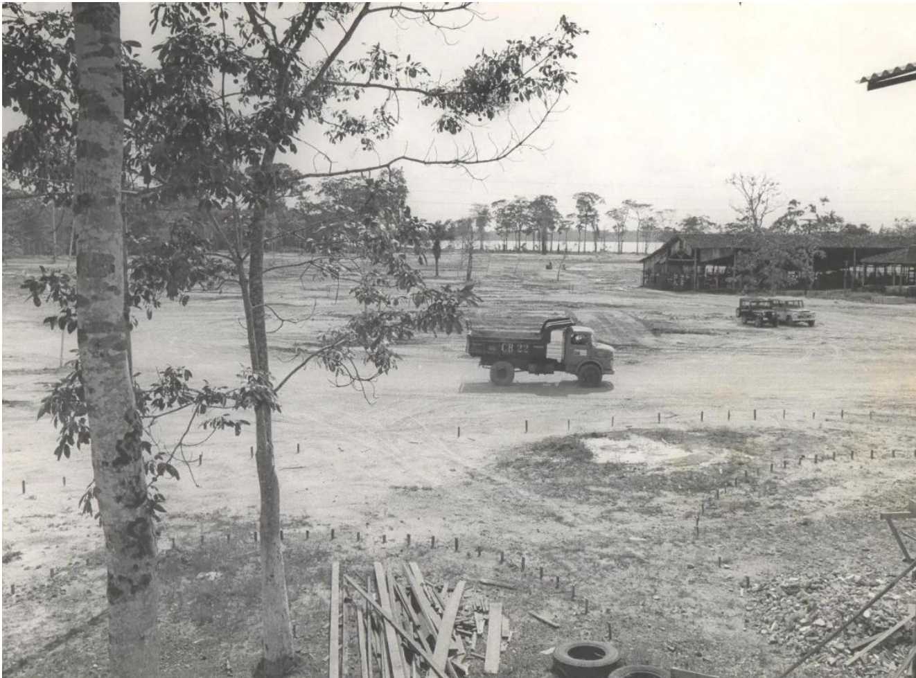
Figura 7 – UFPA: vista parcial da área adquirida para a construção de seu “Núcleo Pioneiro”, em 1967
