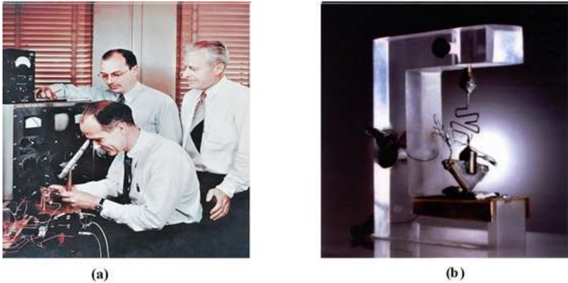
Figura 2.3: (a) Bardeen e Brattain (em pé) e Shockley (sentado), (b) o Réplica do primeiro transistor.
