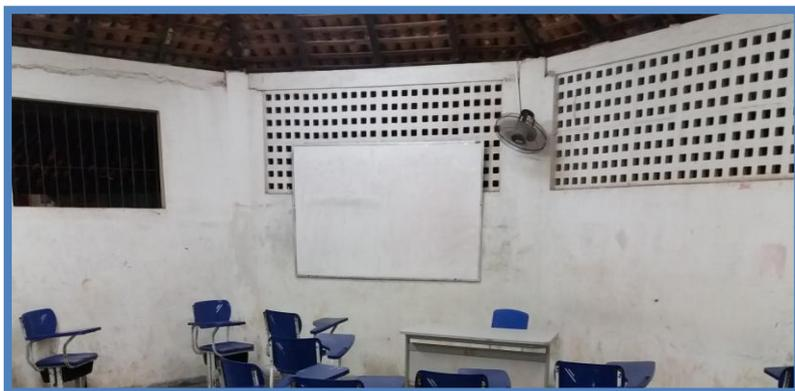
FIGURA - Furos de Ventilação na Sala de Aula
