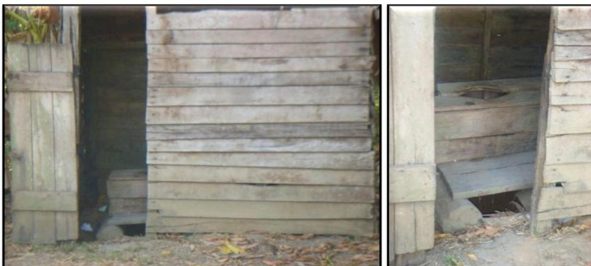
**Fotografia 11 - Sanitário com fossa rudimentar, a) estrutura do sanitário e a entrada; b) detalhe do interior do sanitário.**
