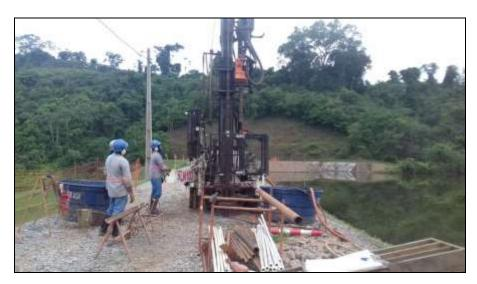
Figura 50: Sondagem na Crista da Barragem, 2017.
