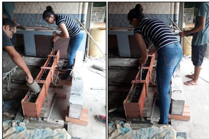
**Figura 3.12 - Concretagem das vigas com adensador mecânico.**
