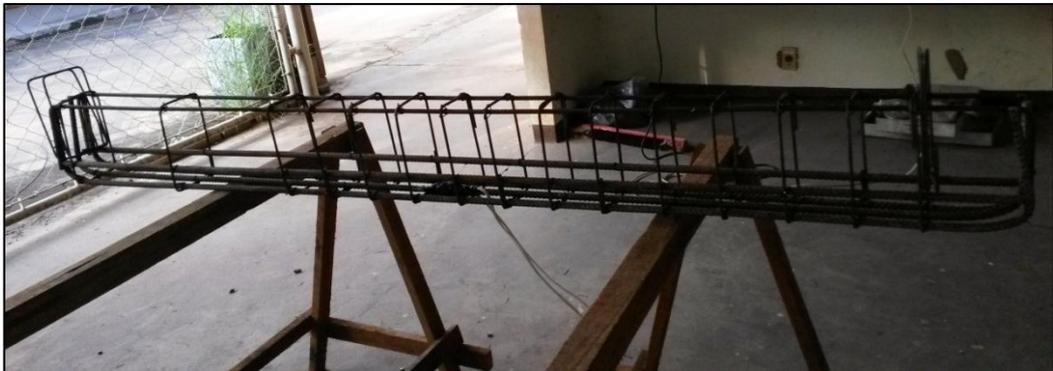
**Figura 3.3 - Armadura executada para a viga.**
