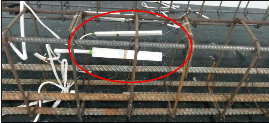
**Figura 3.6 - Strain gages internos do concreto pronto para a execução da concretagem.**
