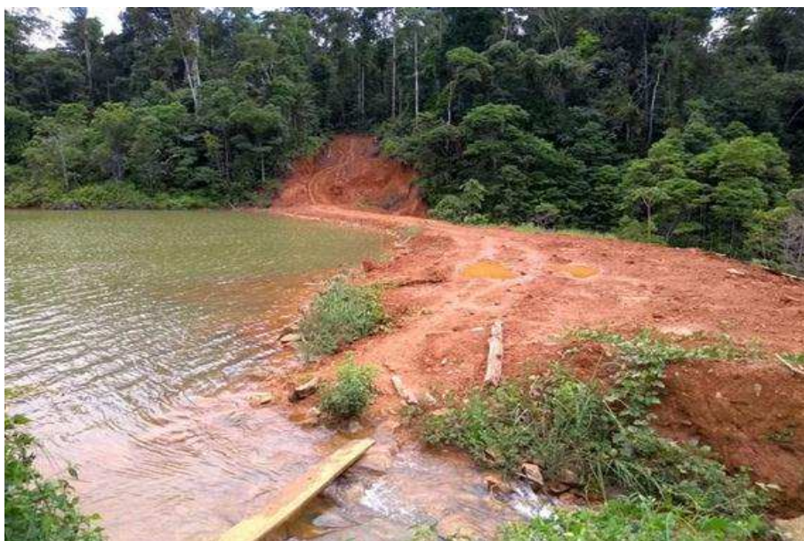
Figura 18 – Abertura de extravasor nna ombreira direita da barragem, em 2018
