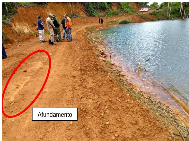
Figura 24 - Afundamento
