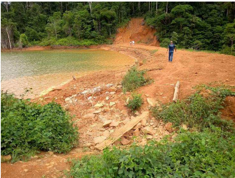
Figura 19 – Rebaixamento do N.A. após a abertura dos extravasores
