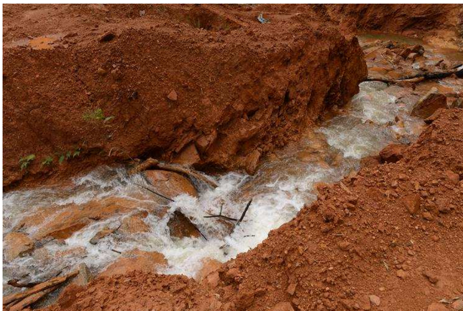
Figura 17 - Abertura de extravasor no corpo da barragem, em 2018
